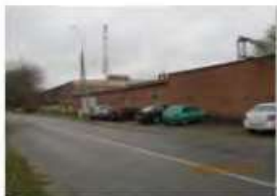
Литер Б (Учебно-производственный корпус) (1)
