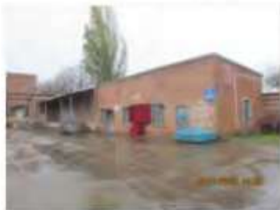
Литер Ж (Склад) (2)
