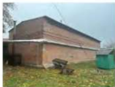
Литер Р (Трубный склад) (1)
