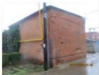
Литер Д1 (Склад) (1)
