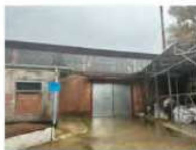
Литер Р (Трубный склад) (3)
