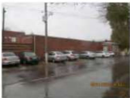
Литер Ж (Склад) (3)
