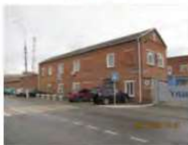
Литер А (Учебно-производственный корпус) (4)
