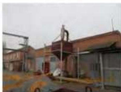
Литер Б (Учебно-производственный корпус) (4)
