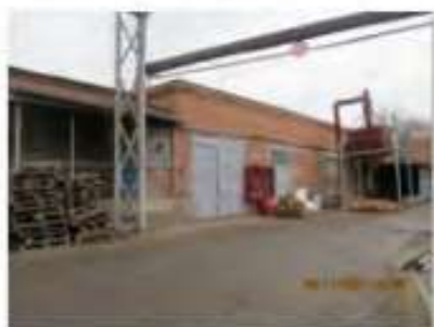
Литер Б (Учебно-производственный корпус) (3)
