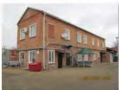
Литер А (Учебно-производственный корпус) (1)
