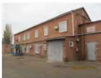
Литер А (Учебно-производственный корпус) (2)
