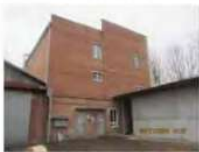
Литер Д (Лабораторно-бытовой корпус) (1)
