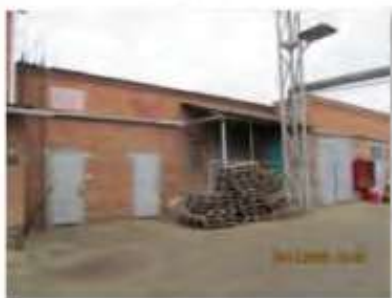
Литер А (Учебно-производственный корпус) (3)
