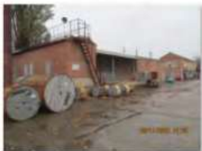
Литер Ж (Склад) (1)
