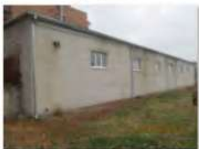
Литер Д (Лабораторно-бытовой корпус) (4)
