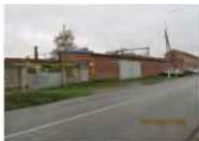
Литер Б (Учебно-производственный корпус) (2)
