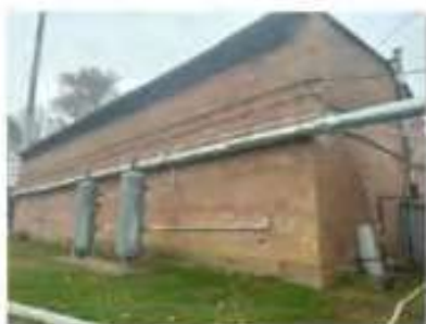
Литер Р (Трубный склад) (2)
