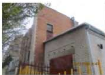
Литер Д (Лабораторно-бытовой корпус) (3)
