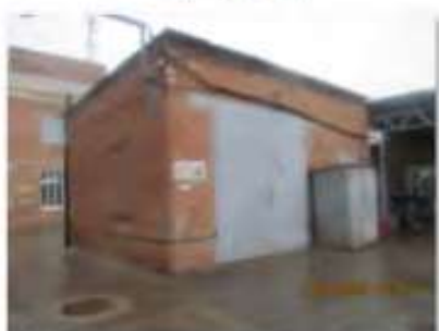
Литер Д1 (Склад) (2)
