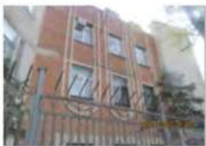
Литер Д (Лабораторно-бытовой корпус) (2)
