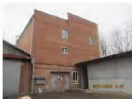
Литер Д (Лабораторно-бытовой корпус) (1)
