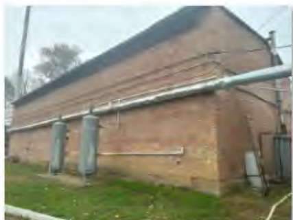
Литер Р (Трубный склад) (2)
