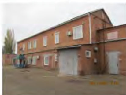
Литер А (Учебно-производственный корпус) (2)
