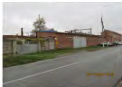
Литер Б (Учебно-производственный корпус) (2)
