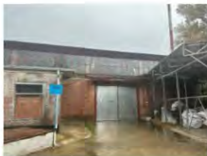
Литер Р (Трубный склад) (3)
