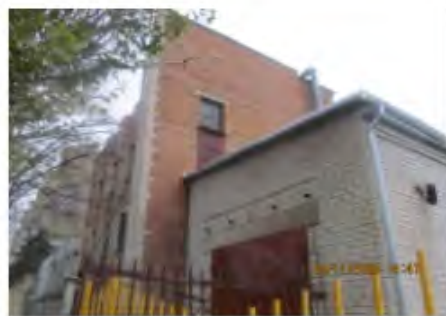
Литер Д (Лабораторно-бытовой корпус) (3)
