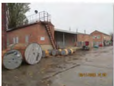
Литер Ж (Склад) (1)
