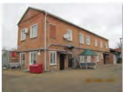
Литер А (Учебно-производственный корпус) (1)
