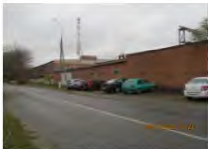
Литер Б (Учебно-производственный корпус) (1)
