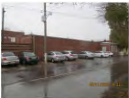
Литер Ж (Склад) (3)
