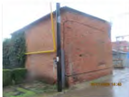
Литер Д1 (Склад) (1)
