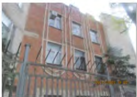
Литер Д (Лабораторно-бытовой корпус) (2)
