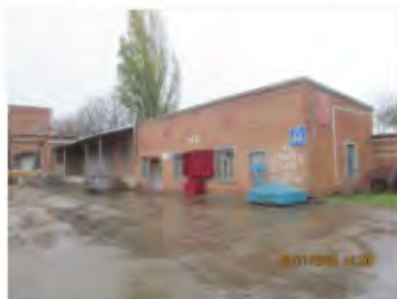
Литер Ж (Склад) (2)
