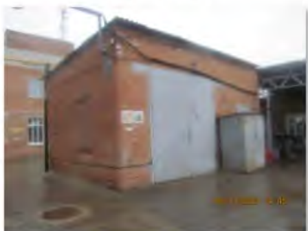
Литер Д1 (Склад) (2)
