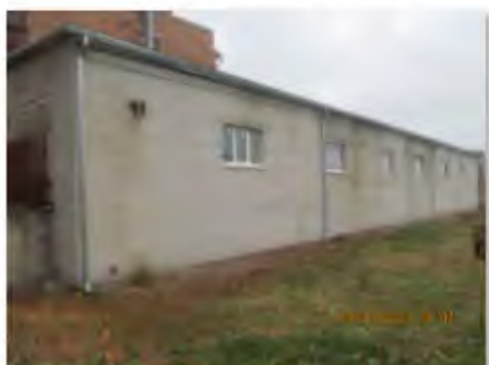
Литер Д (Лабораторно-бытовой корпус) (4)
