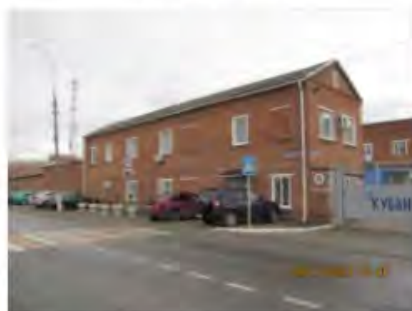
Литер А (Учебно-производственный корпус) (4)
