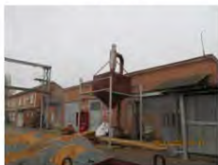
Литер Б (Учебно-производственный корпус) (4)
