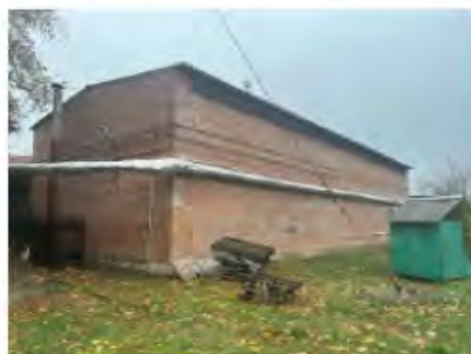
Литер Р (Трубный склад) (1)
