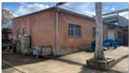
Литер М (Лабораторно-бытовой корпус)
