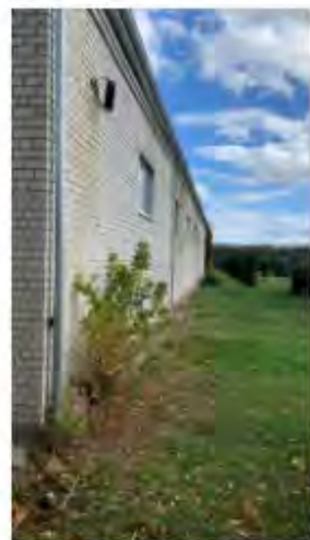
Литер Д (Лабораторно-бытовой корпус) (4)
