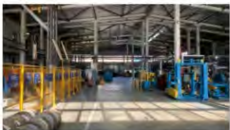
Литер Т (Здание слесарно-механического цеха) (3)
