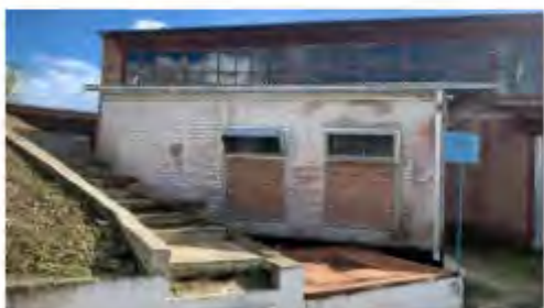
Литер Р (Трубный склад) (2)
