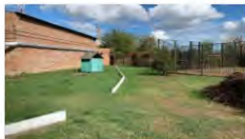
Литер Р (Трубный склад) (3)
