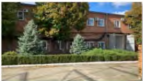
Литер В (Административно-хозяйственное здание) (1)
