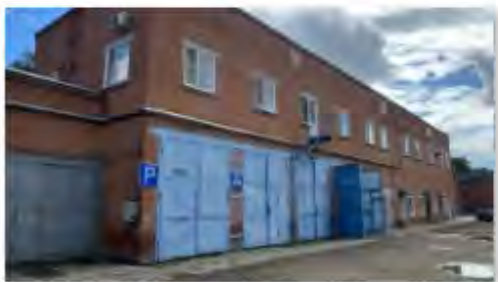
Литер В (Административно-хозяйственное здание) (3)
