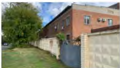
Литер Т (Здание слесарно-механического цеха) (1)
