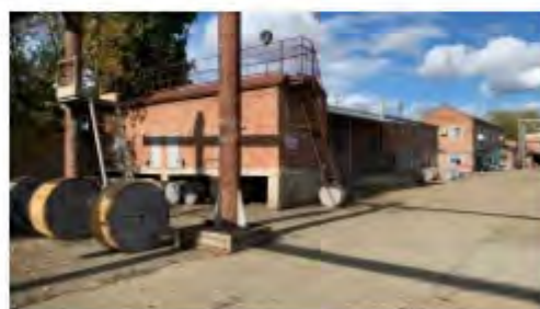
Литер Ж (Склад) (1)
