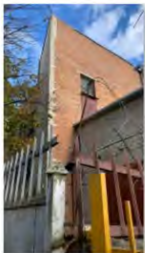
Литер Д (Лабораторно-бытовой корпус) (3)
