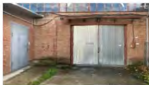
Литер Р (Трубный склад) (1)
