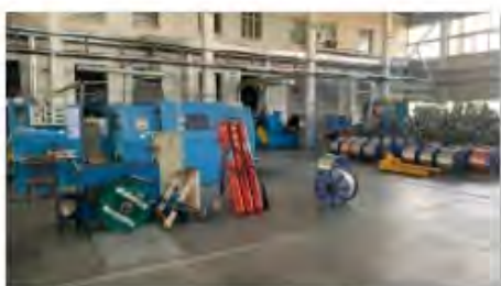
Литер Т (Здание слесарно-механического цеха) (5)
