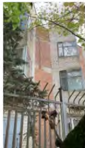
Литер Д (Лабораторно-бытовой корпус) (2)
