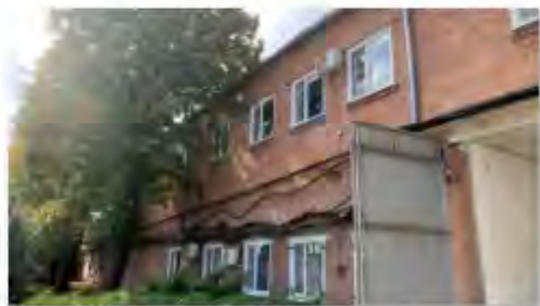
Литер В (Административно-хозяйственное здание) (4)
