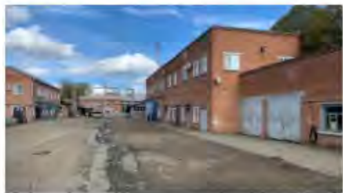
Литер В (Административно-хозяйственное здание) (2)
