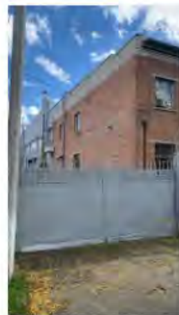
Литер Т (Здание слесарно-механического цеха) (2)
