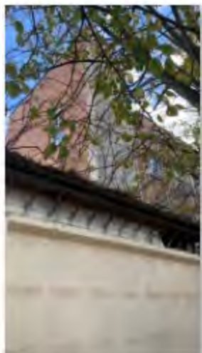
Литер Д (Лабораторно-бытовой корпус) (1)
