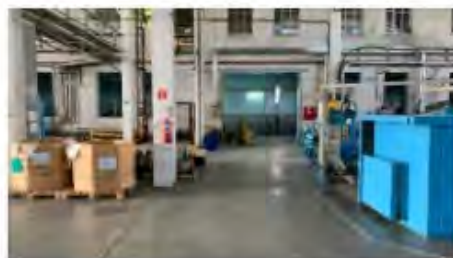
Литер Т (Здание слесарно-механического цеха) (4)
