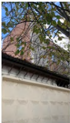
Литер Д (Лабораторно-бытовой корпус) (1)
