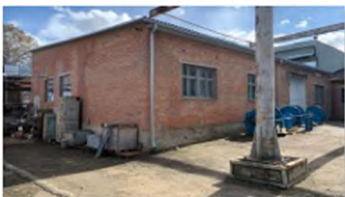
Литер М (Лабораторно-бытовой корпус)
