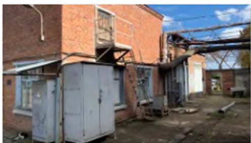
Литер 3 (Склад и Линейный участок) (2)
