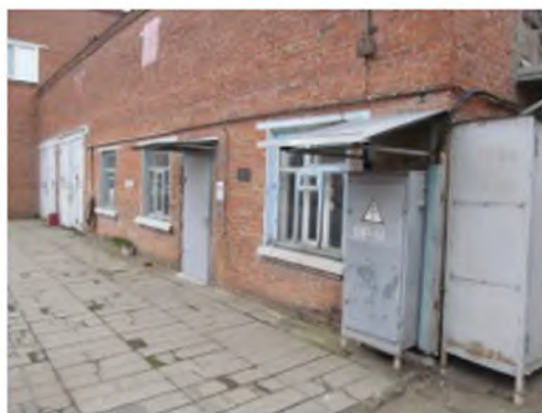
Литер 3 (Склад и Линейный участок) (3)
