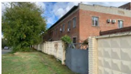
Литер Т (Здание слесарно-механического цеха) (1)
