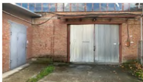
Литер Р (Трубный склад) (1)
