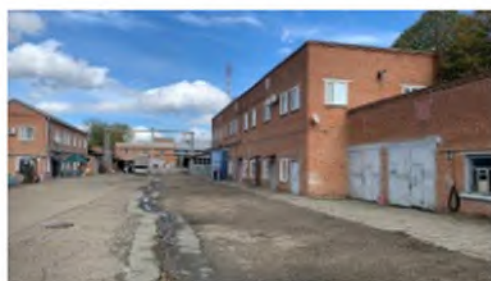
Литер В (Административно-хозяйств енное здание) (2)
