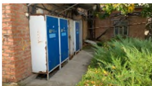
Литер 3 (Склад и Линейный участок) (1)
