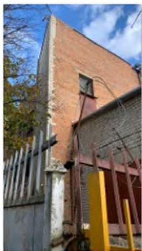
Литер Д (Лабораторно-бытовой корпус) (3)
