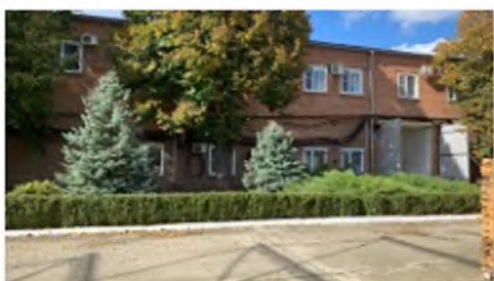
Литер В (Административно-хозяйств енное здание) (1)
