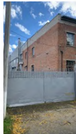
Литер Т (Здание слесарно-механического цеха) (2)
