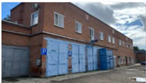
Литер В (Административно-хозяйств енное здание) (3)
