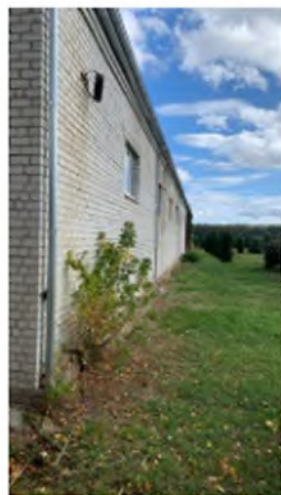
Литер Д (Лабораторно-бытовой корпус) (4)
