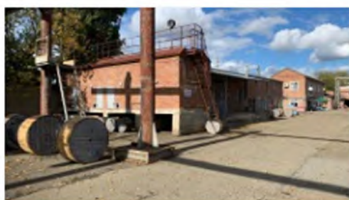
Литер Ж (Склад) (1)
