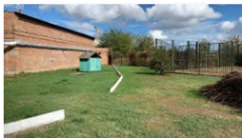
Литер Р (Трубный склад) (3)
