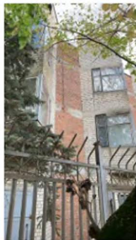
Литер Д (Лабораторно-бытовой корпус) (2)
