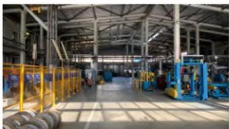
Литер Т (Здание слесарно-механического цеха) (3)
