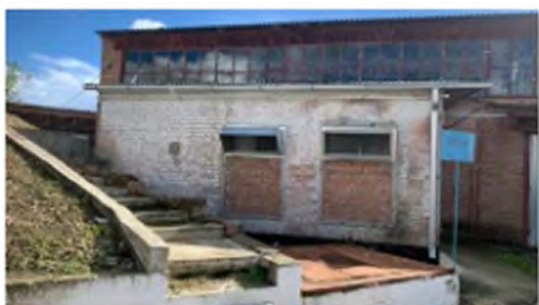
Литер Р (Трубный склад) (2)
