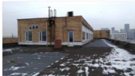
Фото 2. Внешний вид надстройки с крыши (1).
