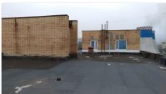
Фото 3. Внешний вид надстройки с крыши (2).
