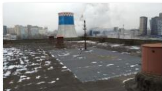
Фото 4. Панорамный вид с крыши.
