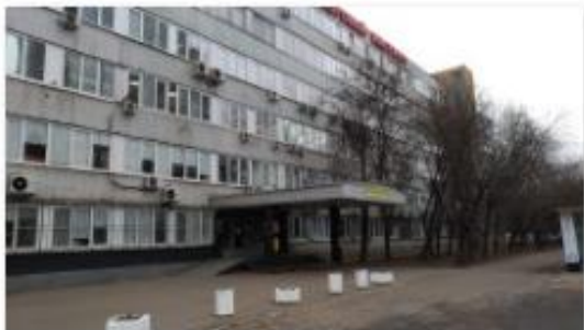
Фото 1. Внешний вид здания - Входная группа
