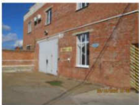
Литер Т (Здание слесарно-механического цеха) (3)
