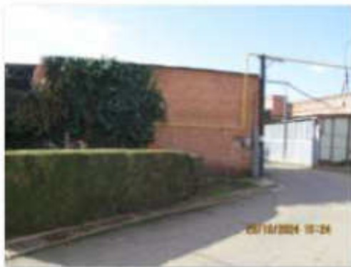
Литер Р (Трубный склад) (1)
