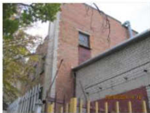
Литер Д (Лабораторно-бытовой корпус) (1)
