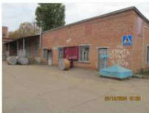
Литер Ж (Склад) (2)
