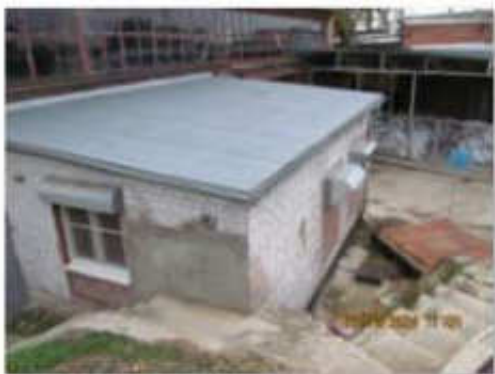
Литер Р (Трубный склад) (2)
