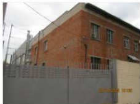
Литер Т (Здание слесарно-механического цеха) (6)
