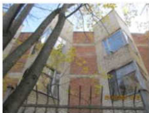
Литер Д (Лабораторно-бытовой корпус) (3)
