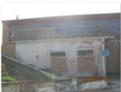
Литер Р (Трубный склад) (4)
