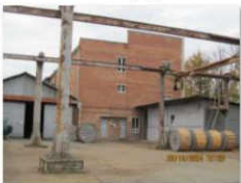
Литер Д (Лабораторно-бытовой корпус) (2)
