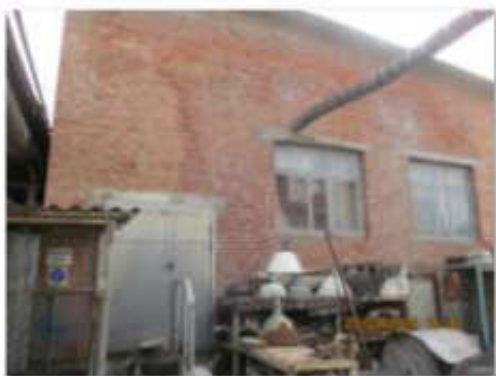
Литер М (Лабораторно-бытовой корпус) (1)
