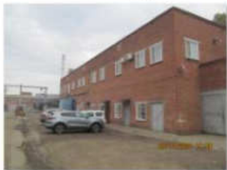
Литер В (Административно-хозяйственное здание) (3)
