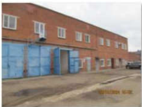
Литер В (Административно-хозяйственное здание) (4)
