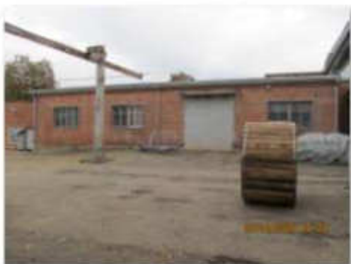
Литер М (Лабораторно-бытовой корпус) (3)
