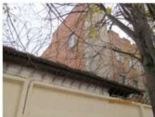
Литер Д (Лабораторно-бытовой корпус) (5)
