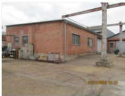
Литер М (Лабораторно-бытовой корпус) (2)
