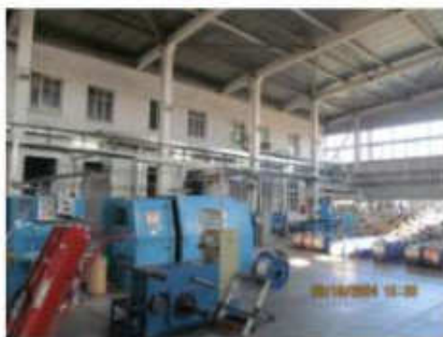
Литер Т (Здание слесарно-механического цеха) (2)
