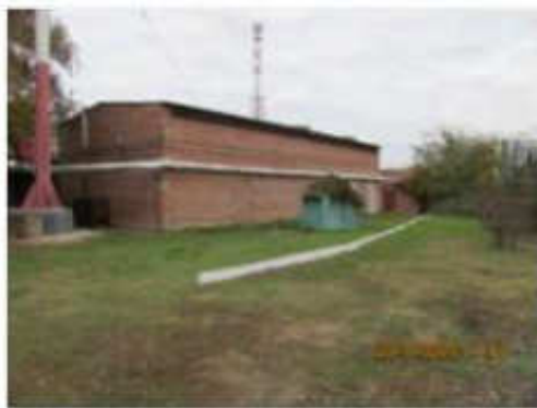
Литер Р (Трубный склад) (3)
