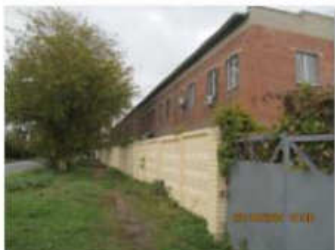
Литер Т (Здание слесарно-механического цеха) (5)
