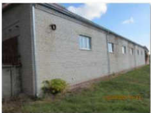
Литер Д (Лабораторно-бытовой корпус) (4)
