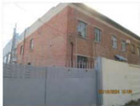
Литер Т (Здание слесарно-механического цеха) (4)
