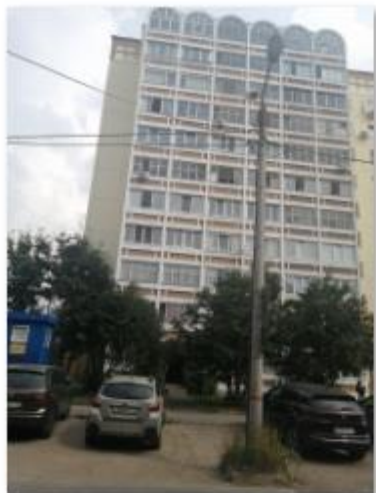
Внешний вид здания
