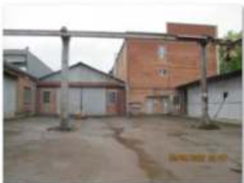
Литер Д (Лабораторно-бытовой корпус) (1)
