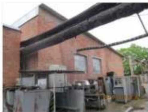
Литер М (Лабораторно-бытовой корпус) (2)
