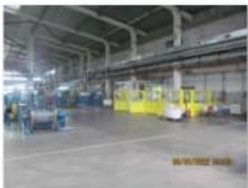
Литер С (Здание ОВК) (1)
