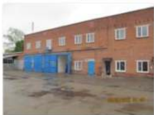
Литер В (Административно-хозяйственное здание) (1)
