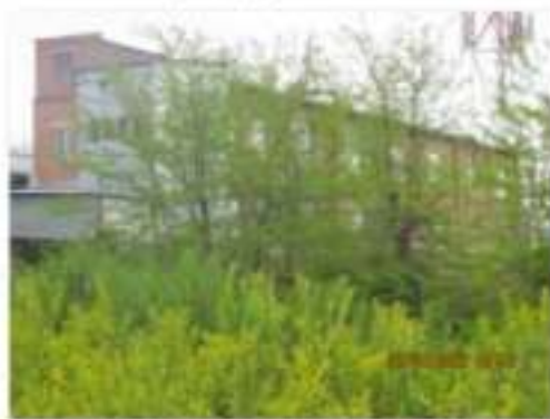
Литер С (Здание ОВК) (2)
