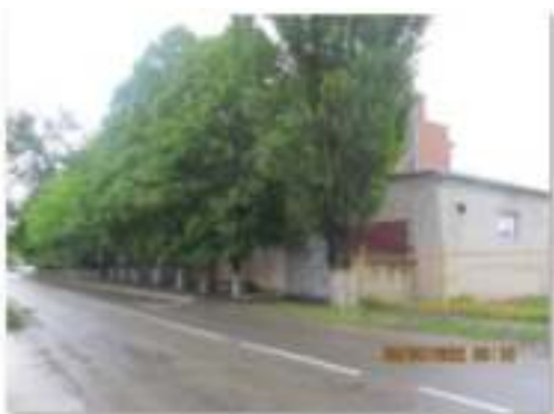
Литер Д (Лабораторно-бытовой корпус) (3)
