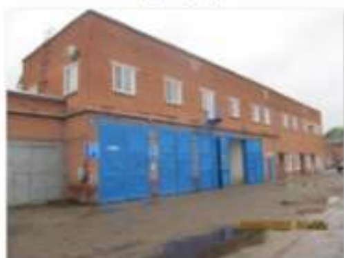
Литер В (Административно-хозяйственное здание) (3)
