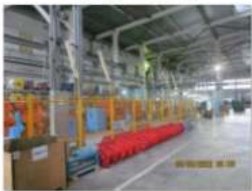
Литер Т (Здание слесарно-механического цеха) (1)
