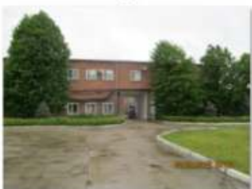
Литер В (Административно-хозяйственное здание) (2)
