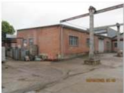
Литер М (Лабораторно-бытовой корпус) (1)
