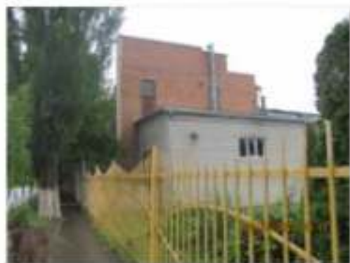
Литер Д (Лабораторно-бытовой корпус) (2)
