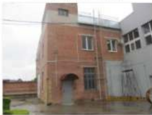
Литер Т (Здание слесарно-механического цеха) (2)
