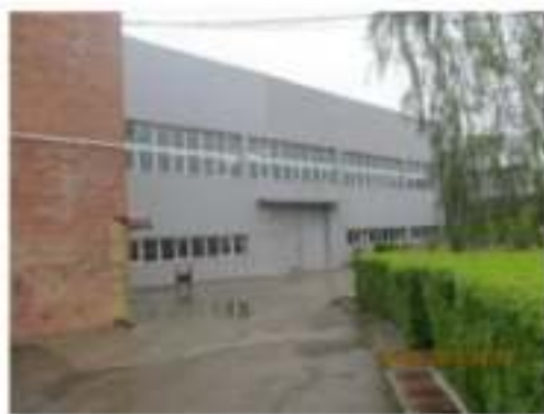
Литер Х (Нежилое здание - цех) (1)
