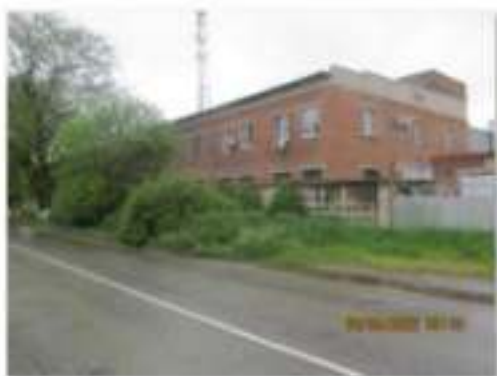
Литер Т (Здание слесарно-механического цеха) (3)
