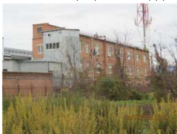
Фото.36 Литер С (Здание ОВК) (4)
