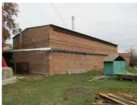
Фото.32 Литер Р (Трубный склад) (3)
