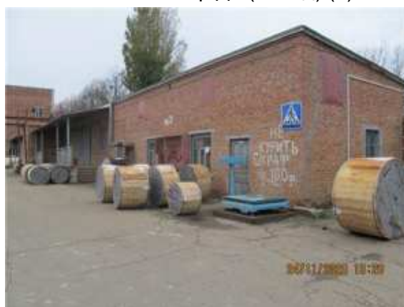
Фото.16 Литер Ж (Склад) (1)
