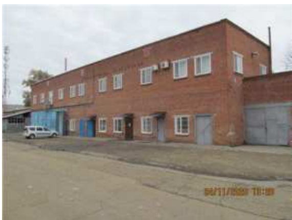
Фото.7 Литер В (Административно-хозяйственное здание) (1)
