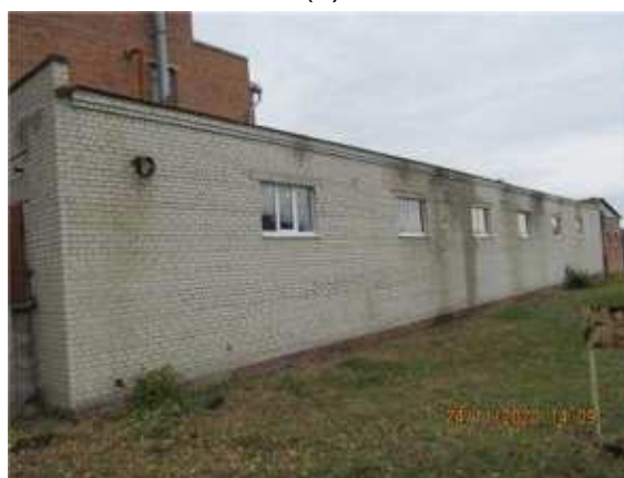
Фото.12 Литер Д (Лабораторно-бытовой корпус) (4)
