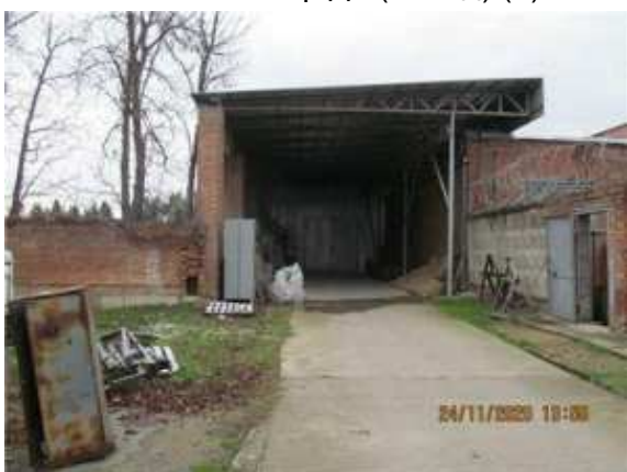
Фото.15 Литер Д2 (Навес)
