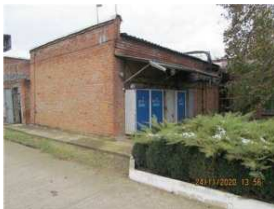
Фото.28 Литер О (Лабораторно-бытовой корпус) (1)
