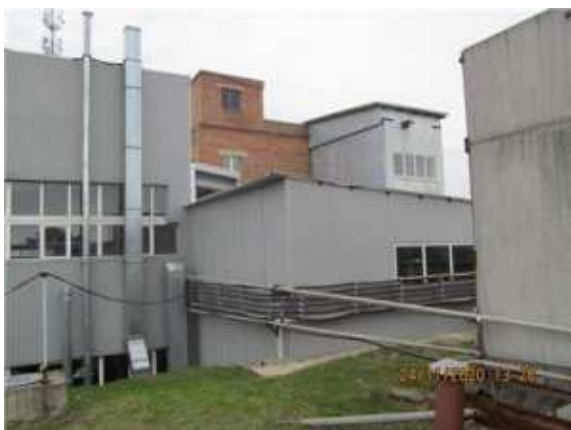
Фото.33 Литер С (Здание ОВК) (1)
