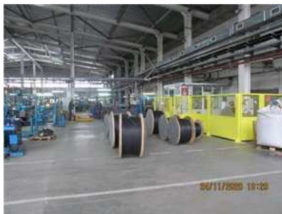
Фото.34 Литер С (Здание ОВК) (2)
