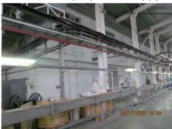
Фото.35 Литер С (Здание ОВК) (3)
