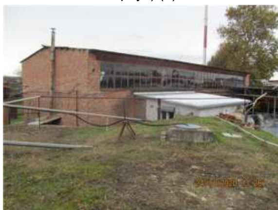
Фото.31 Литер Р (Трубный склад) (2)
