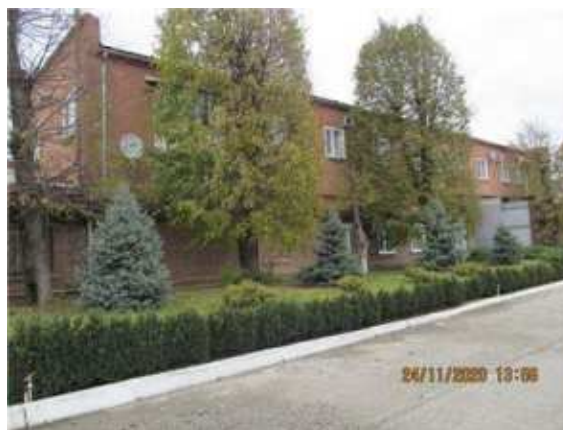
Фото.8 Литер В (Административно-хозяйственное здание) (2)
