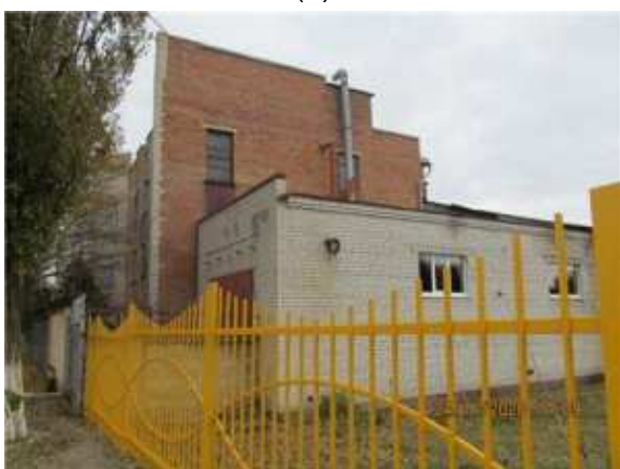
Фото.11 Литер Д (Лабораторно-бытовой корпус) (3)
