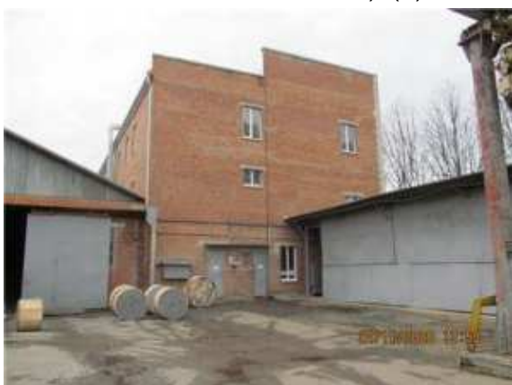
Фото.9 Литер Д (Лабораторно-бытовой корпус) (1)
