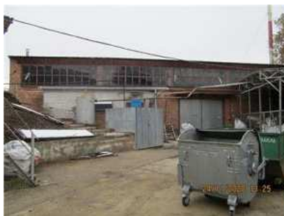
Фото.30 Литер Р (Трубный склад) (1)
