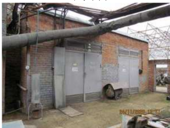
Фото.29 Литер О (Лабораторно-бытовой корпус) (2)
