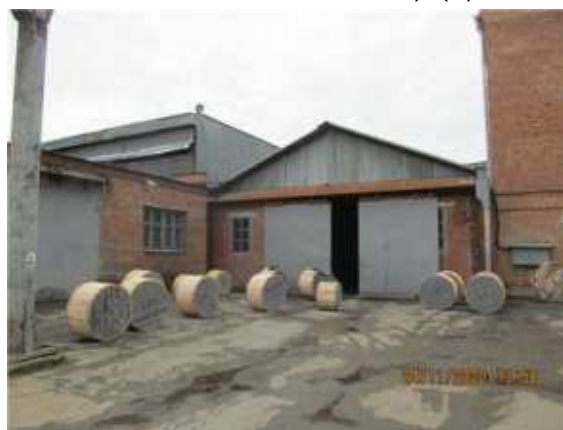
Фото.10 Литер Д (Лабораторно-бытовой корпус) (2)
