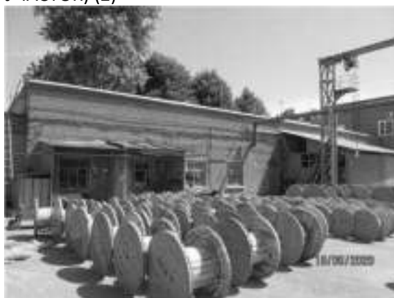
Фото 52 ЛИТЕР И (СКЛАД И ЛИНЕЙНЫЙ УЧАСТОК) (4)
