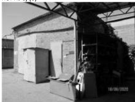
Фото 36 ЛИТЕР Д1 (СКЛАД) (1)
