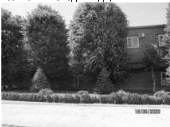
Фото 23 ЛИТЕР В (АДМИНИСТРАТИВНО-ХОЗЯЙСТВЕННОЕ ЗДАНИЕ) (4)
