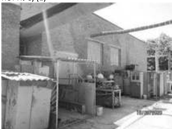
Фото 61 ЛИТЕР М (ЛАБОРАТОРНО-БЫТОВОЙ КОРПУС) (3)
