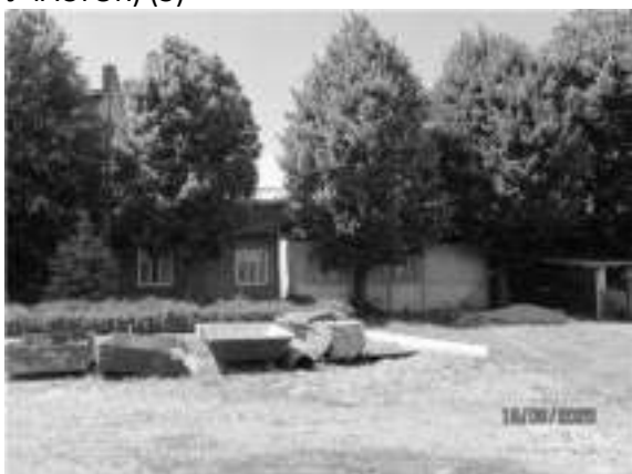
Фото 49 ЛИТЕР И (СКЛАД И ЛИНЕЙНЫЙ УЧАСТОК) (1)
