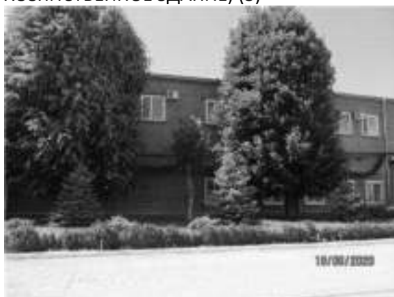
Фото 24 ЛИТЕР В (АДМИНИСТРАТИВНО-ХОЗЯЙСТВЕННОЕ ЗДАНИЕ) (5)
