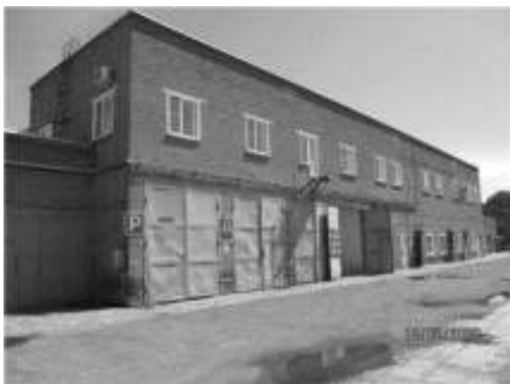
Фото 21 ЛИТЕР В (АДМИНИСТРАТИВНО-ХОЗЯЙСТВЕННОЕ ЗДАНИЕ) (2)
