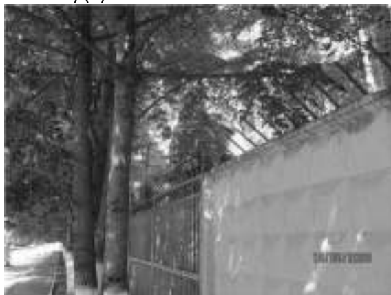
Фото 32 ЛИТЕР Д (ЛАБОРАТОРНО-БЫТОВОЙ КОРПУС) (6)
