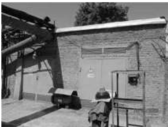
Фото 65 ЛИТЕР О (ЛАБОРАТОРНО-БЫТОВОЙ КОРПУС) (2)
