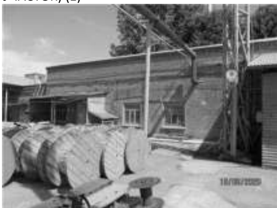
Фото 51 ЛИТЕР И (СКЛАД И ЛИНЕЙНЫЙ УЧАСТОК) (3)
