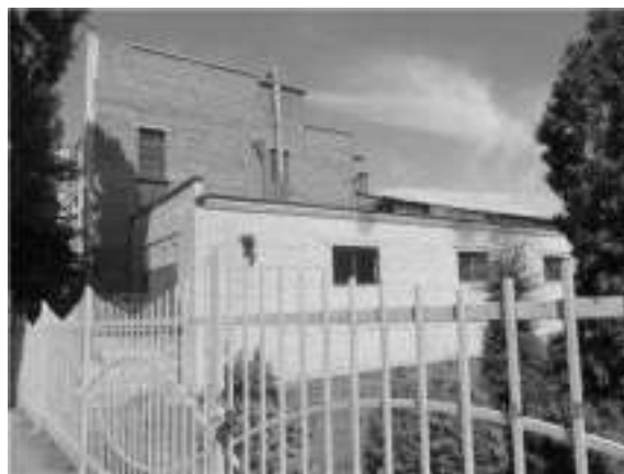
Фото 34 ЛИТЕР Д (ЛАБОРАТОРНО-БЫТОВОЙ КОРПУС) (8)
