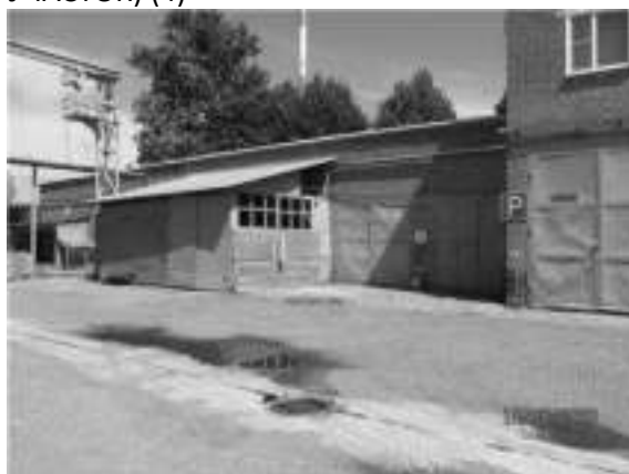
Фото 50 ЛИТЕР И (СКЛАД И ЛИНЕЙНЫЙ УЧАСТОК) (2)
