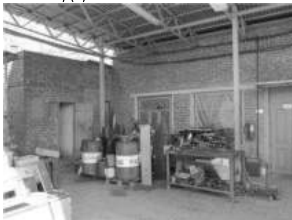
Фото 56 ЛИТЕР К (СКЛАД И ЛИНЕЙНЫЙ УЧАСТОК) (4)
