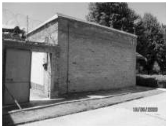
Фото 66 ЛИТЕР О (ЛАБОРАТОРНО-БЫТОВОЙ КОРПУС) (3)
