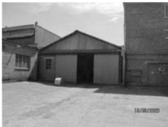
Фото 28 ЛИТЕР Д (ЛАБОРАТОРНО-БЫТОВОЙ КОРПУС) (2)
