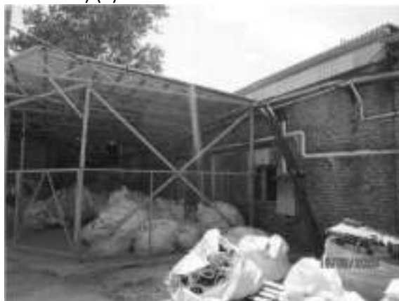
Фото 58 ЛИТЕР К (СКЛАД И ЛИНЕЙНЫЙ УЧАСТОК) (6)
