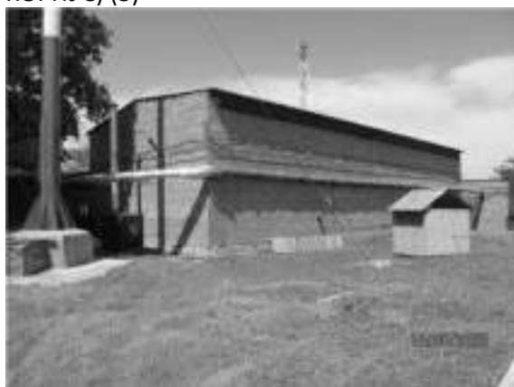
Фото 68 ЛИТЕР Р (ТРУБНЫЙ СКЛАД) (1)
