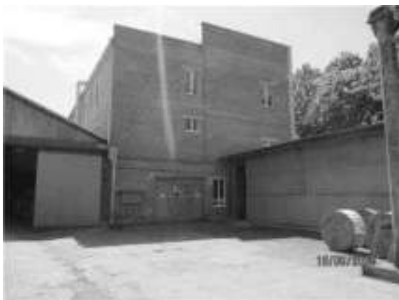
Фото 27 ЛИТЕР Д (ЛАБОРАТОРНО-БЫТОВОЙ КОРПУС) (1)
