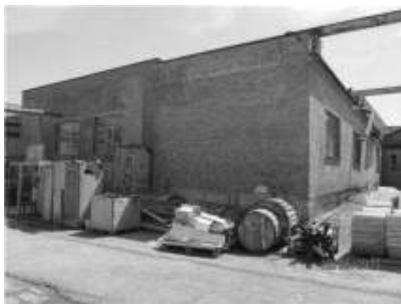
Фото 60 ЛИТЕР М (ЛАБОРАТОРНО-БЫТОВОЙ КОРПУС) (2)
