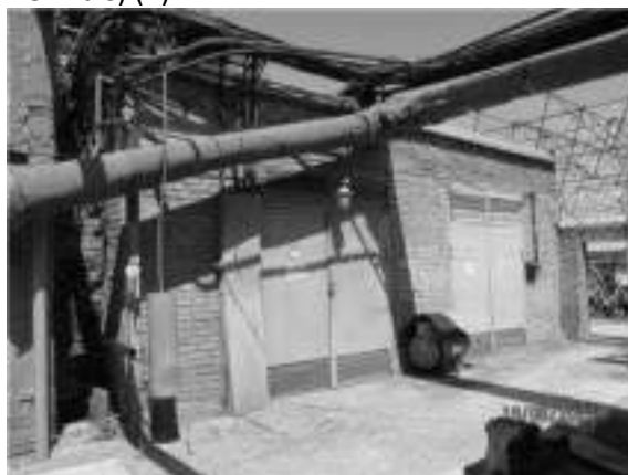
Фото 64 ЛИТЕР О (ЛАБОРАТОРНО-БЫТОВОЙ КОРПУС) (1)
