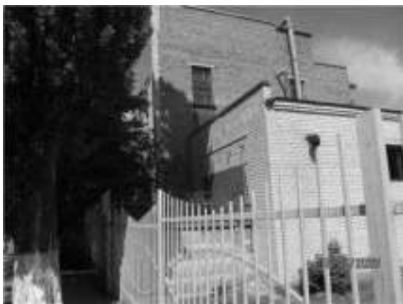
Фото 33 ЛИТЕР Д (ЛАБОРАТОРНО-БЫТОВОЙ КОРПУС) (7)
