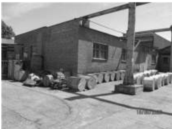
Фото 59 ЛИТЕР М (ЛАБОРАТОРНО-БЫТОВОЙ КОРПУС) (1)
