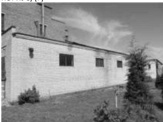
Фото 35 ЛИТЕР Д (ЛАБОРАТОРНО-БЫТОВОЙ КОРПУС) (9)
