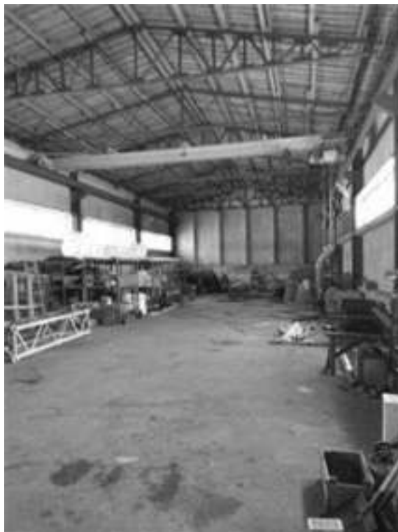
Фото.14 Здание материального склада, лит. Р.Р1.р (3)
