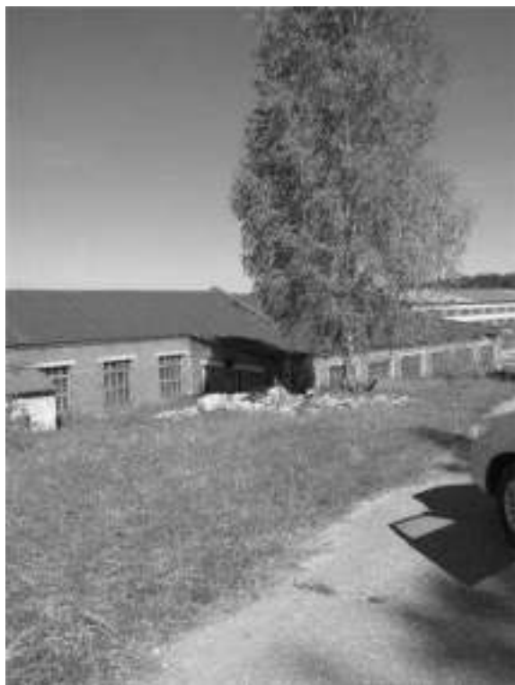
Фото.35 Здание цеха отделки кузовов, лит. М.м (1)
