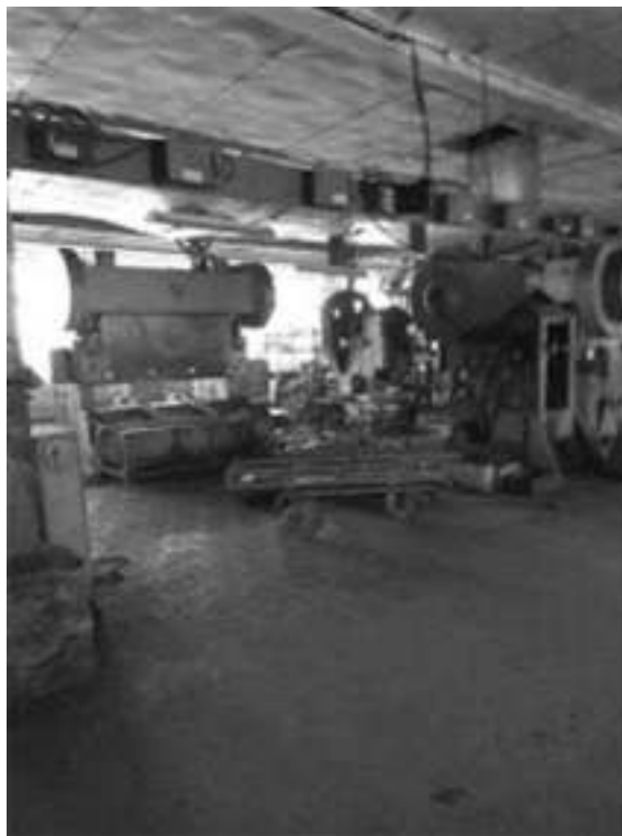
Фото.38 Здание цеха отделки кузовов, лит. М.м (4)
