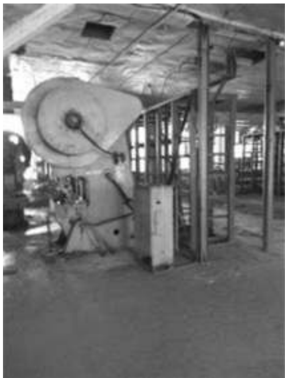
Фото.39 Здание цеха отделки кузовов, лит. М.м (5)
