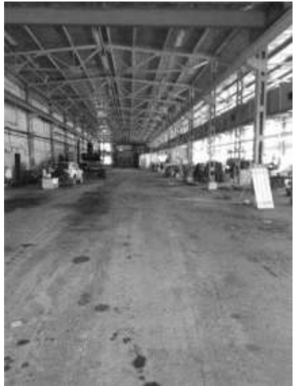
Фото.24 Здание сборочного цеха, лит. О.о (4)
