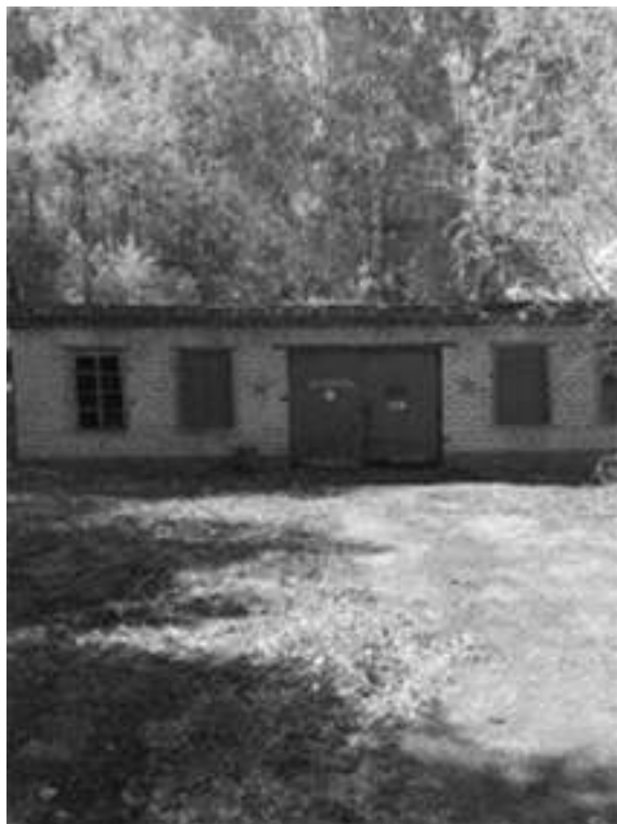
Фото.26 Здание склада ГСМ, лит.С (2)
