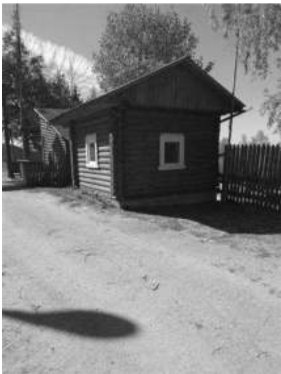
Фото.19 Здание проходной, лит.А, а (1)
