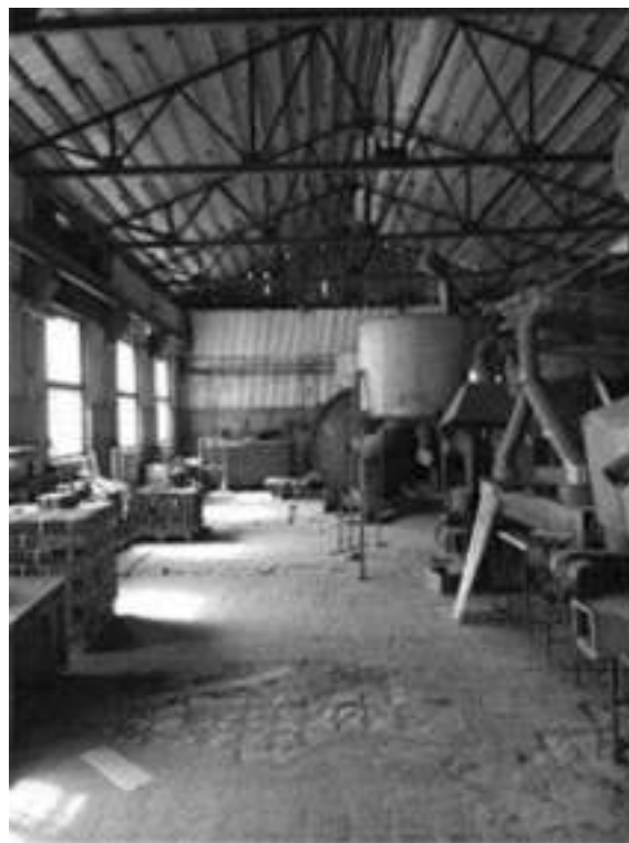
Фото.32 Здание участка сборки транспортеров, лит.К (2)
