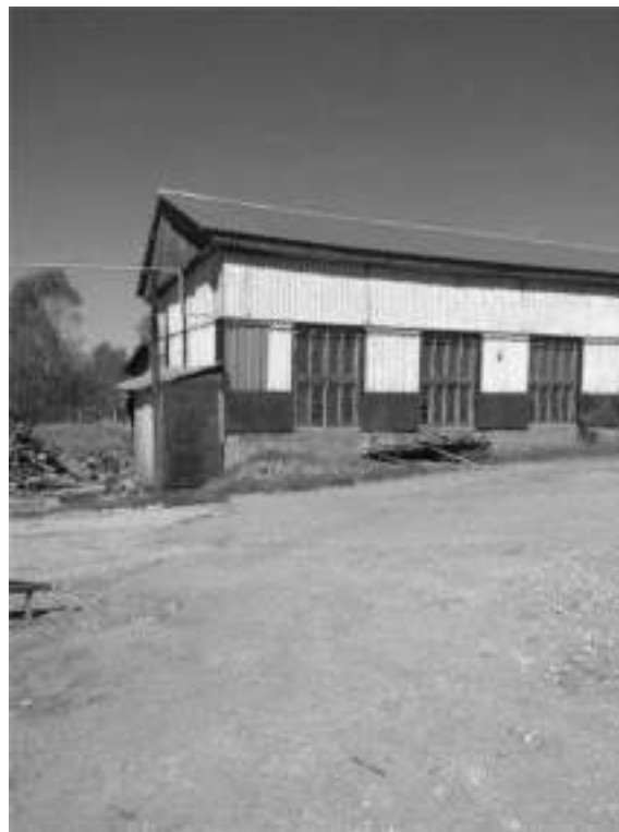
Фото.34 Здание участка сборки транспортеров, лит.К (4)
