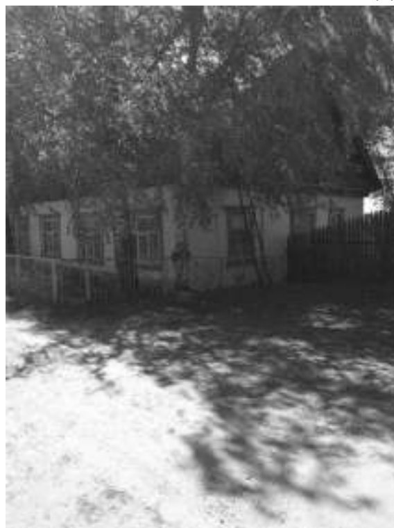
Фото.4 Здание конторы, лит.Х (1)
