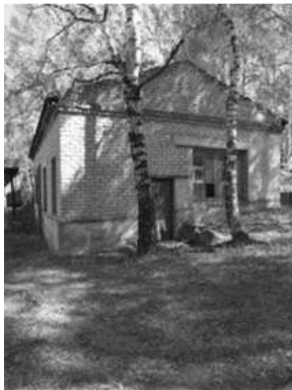
Фото.2 Здание компрессорной, лит.З (2)
