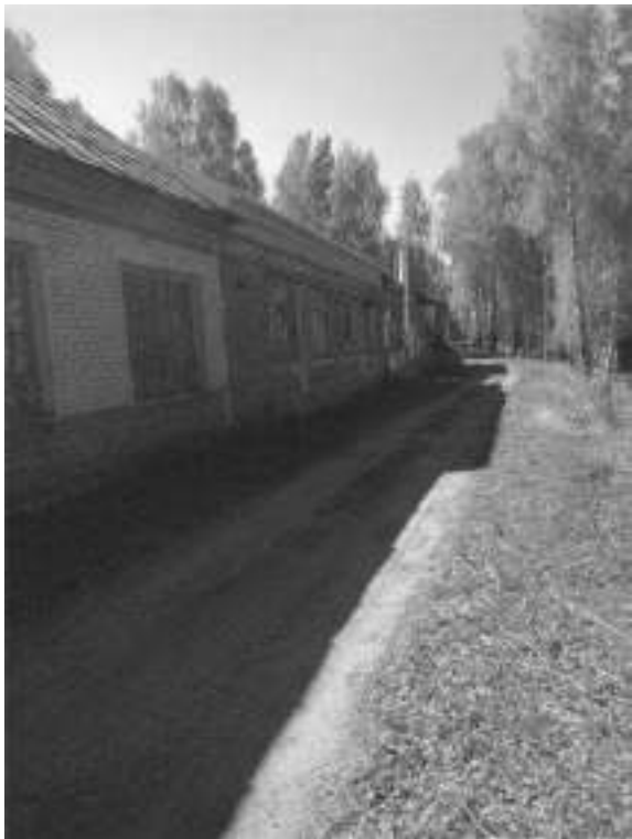
Фото.17 Здание механического цеха, лит. Н.н (2)
