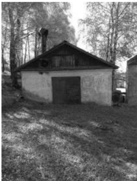
Фото.3 Здание компрессорной, лит.З (3)
