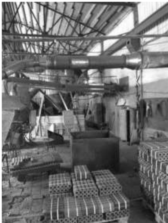
Фото.33 Здание участка сборки транспортеров, лит.К (3)
