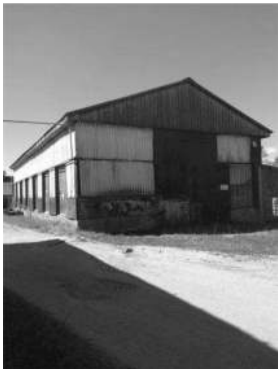
Фото.31 Здание участка сборки транспортеров, лит.К (1)
