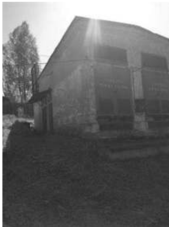
Фото.30 Здание трансформаторной подстанции, лит.Ж (2)
