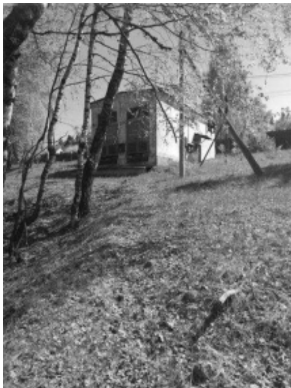
Фото.29 Здание трансформаторной подстанции, лит.Ж (1)
