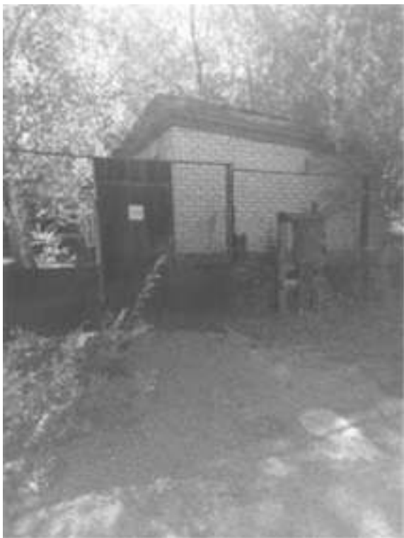
Фото.25 Здание склада ГСМ, лит.С (1)
