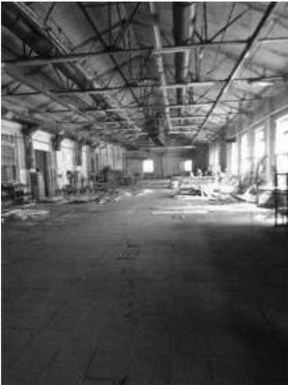
Фото.23 Здание сборочного цеха, лит. О.о (3)
