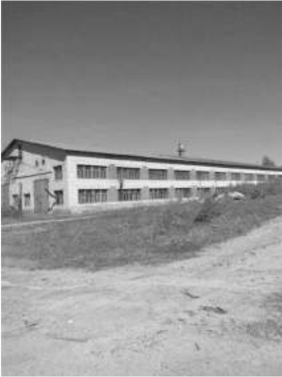
Фото.21 Здание сборочного цеха, лит. О.о (1)
