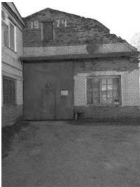
Фото.16 Здание механического цеха, лит. Н.н (1)
