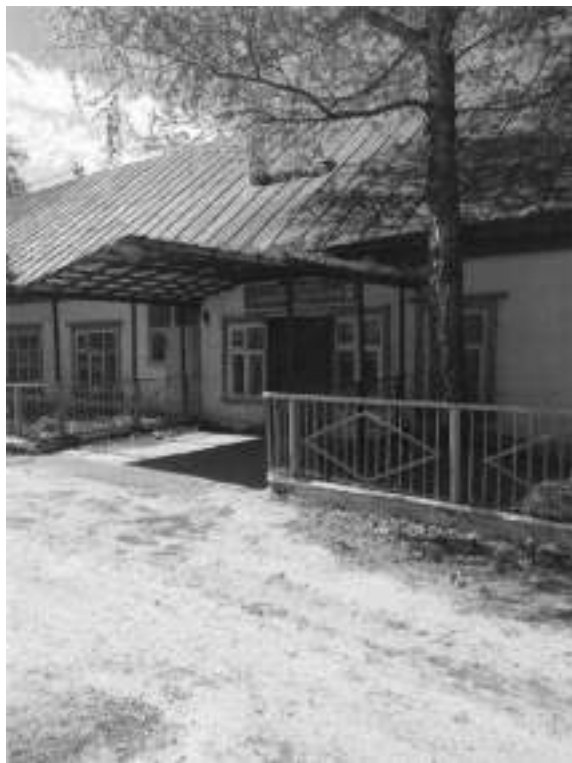
Фото.6 Здание конторы, лит.Х (3)
