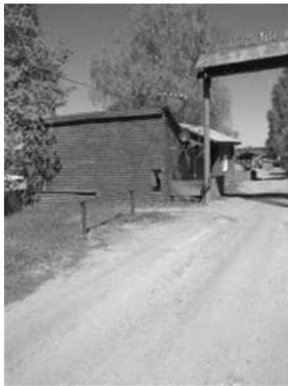
Фото.20 Здание проходной, лит.А, а (2)
