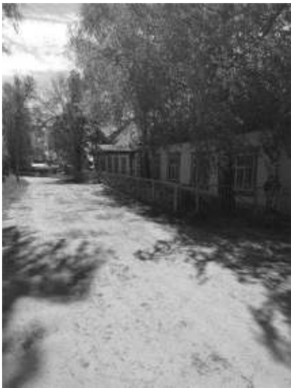
Фото.5 Здание конторы, лит.Х (2)
