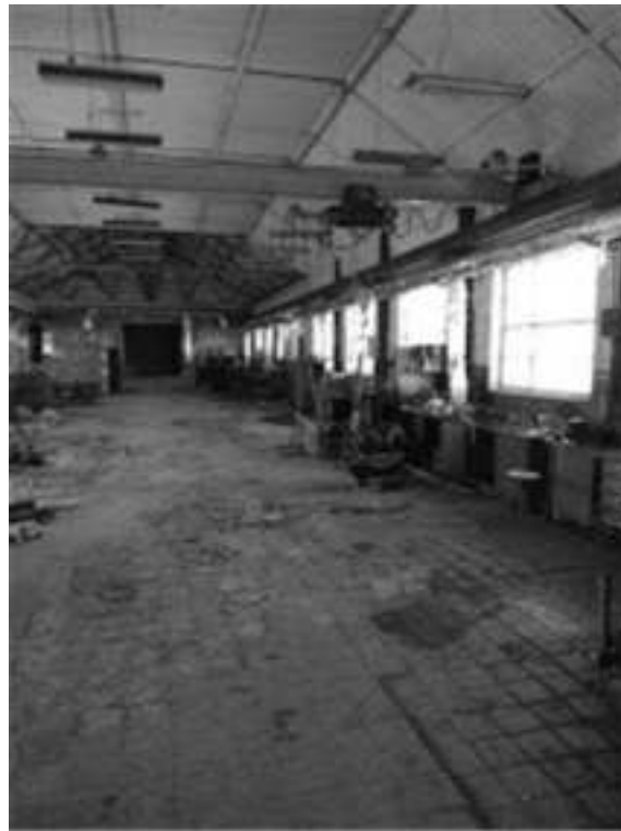
Фото.18 Здание механического цеха, лит. Н.н (3)
