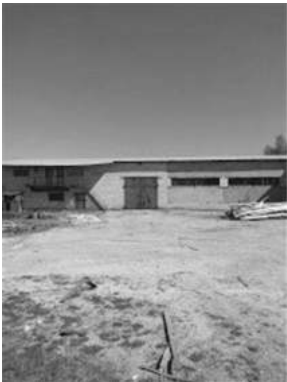
Фото.13 Здание материального склада, лит. Р.Р1.р (2)
