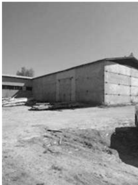
Фото.12 Здание материального склада, лит. Р.Р1.р (1)
