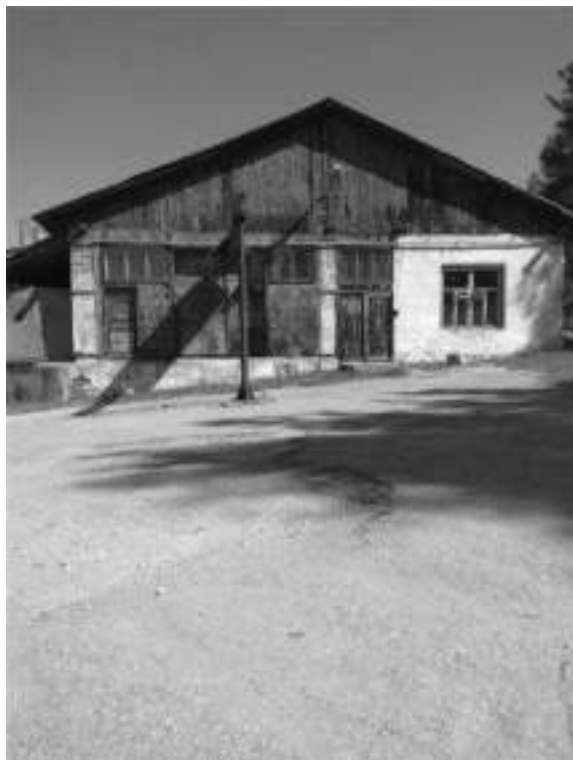
Фото.37 Здание цеха отделки кузовов, лит. М.м (3)
