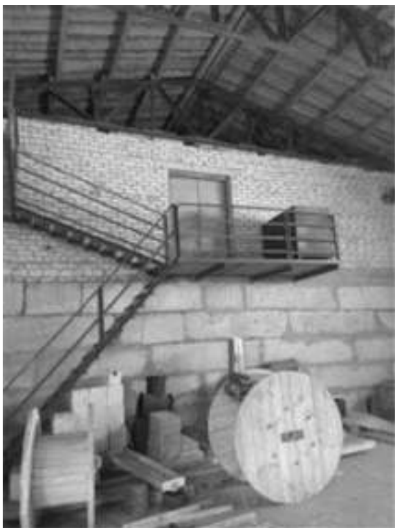
Фото.15 Здание материального склада, лит. Р.Р1.р (4)
