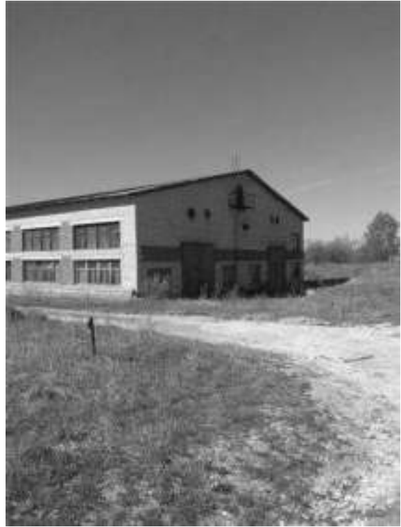
Фото.22 Здание сборочного цеха, лит. О.о (2)
