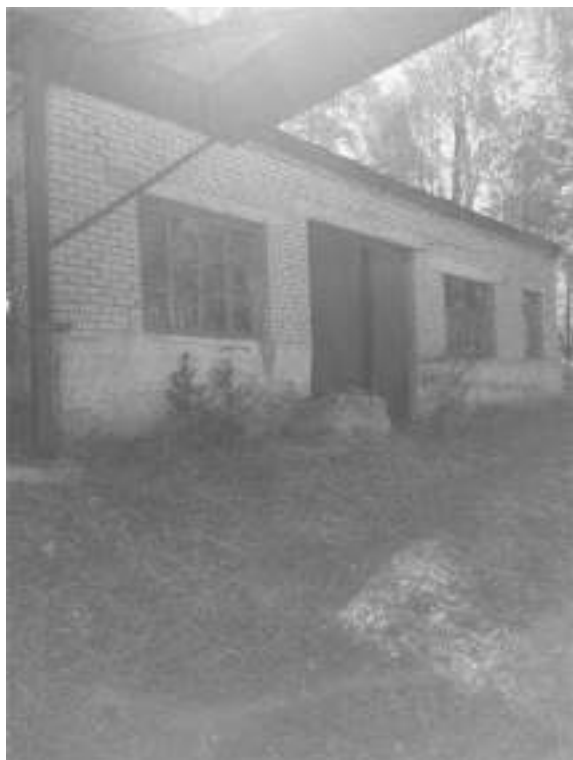
Фото.1 Здание компрессорной, лит.З (1)
