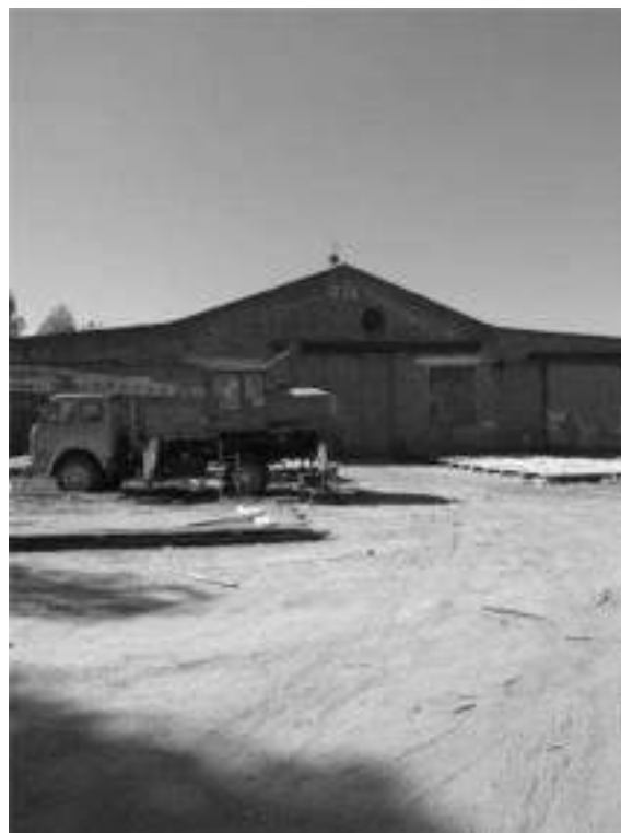
Фото.36 Здание цеха отделки кузовов, лит. М.м (2)
