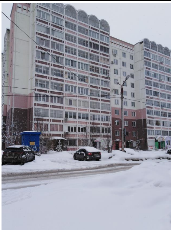
Фото.1 Внешний вид здания (1)
