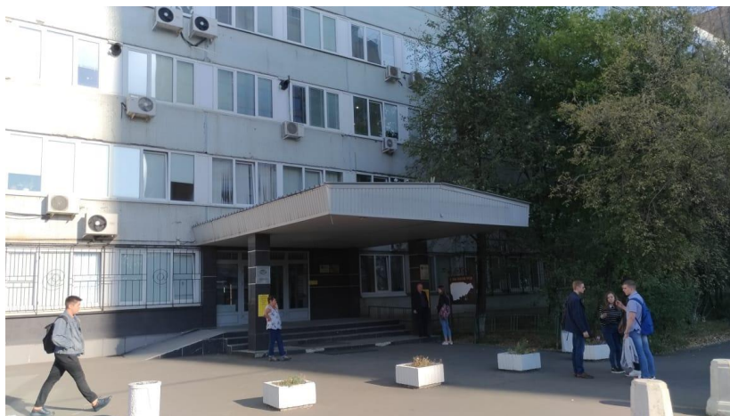
Фото.1 Внешний вид здания
