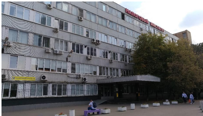
Фото.2 Внешний вид здания
