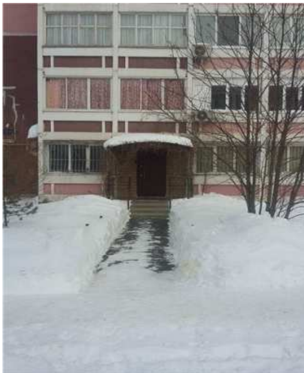
Фото.2 Внешний вид здания и входная группа (2)
