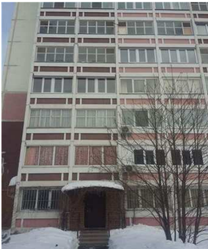
Фото.1 Внешний вид здания и входная группа (1)
