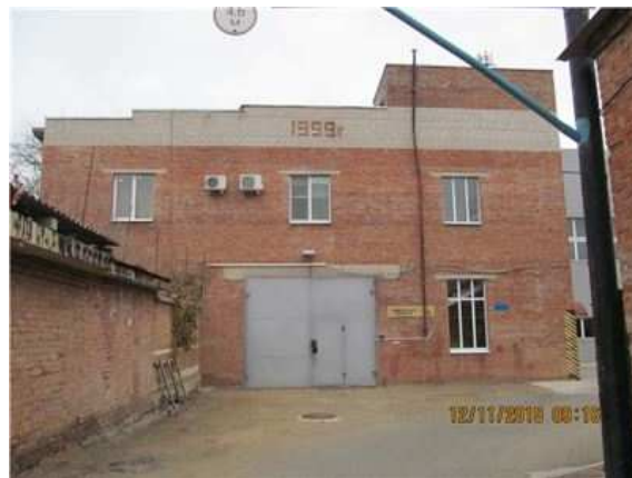
Фото.44 Литер Т (Здание слесарно-механического цеха) (1)
