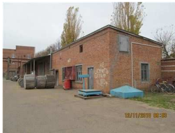
Фото.20 Литер Ж (Склад) (1)
