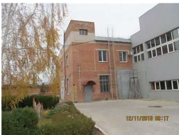
Фото.45 Литер Т (Здание слесарно-механического цеха) (2)
