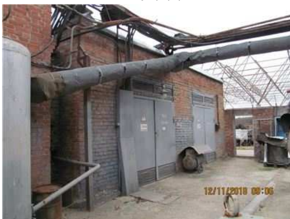
Фото.35 Литер О (Лабораторно-бытовой корпус) (1)
