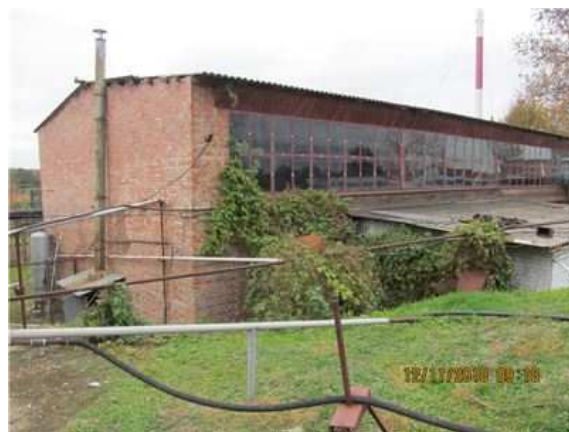
Фото.38 Литер Р (Трубный склад) (3)
