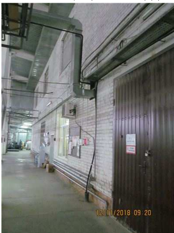
Фото.41 Литер С (Здание ОВК) (4)
