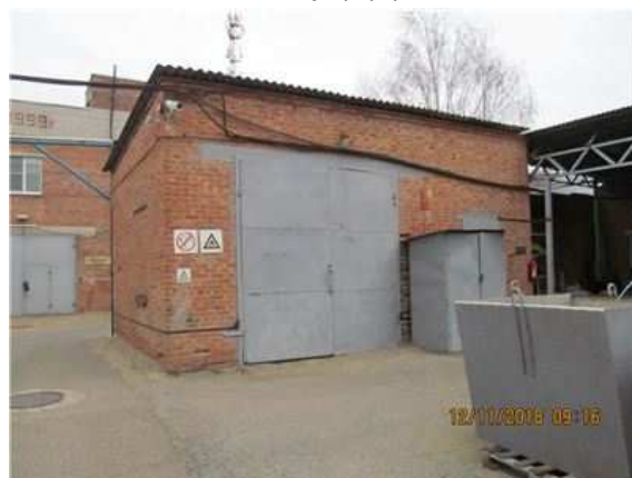
Фото.16 Литер Д1 (Склад) (1)
