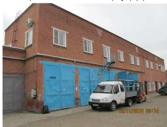
Фото.12 Литер В (Административно-хозяйственное здание) (5)
