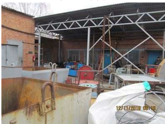
Фото.29 Литер К (Склад и Линейный участок) (3)
