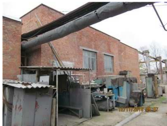
Фото.32 Литер М (Лабораторно-бытовой корпус) (3)
