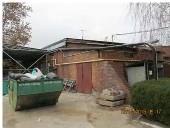
Фото.30 Литер К (Склад и Линейный участок) (5)
