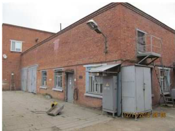
Фото.23 Литер З (Склад и Линейный участок) (2)
