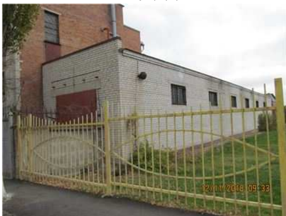
Фото.15 Литер Д (Лабораторно-бытовой корпус) (6)
