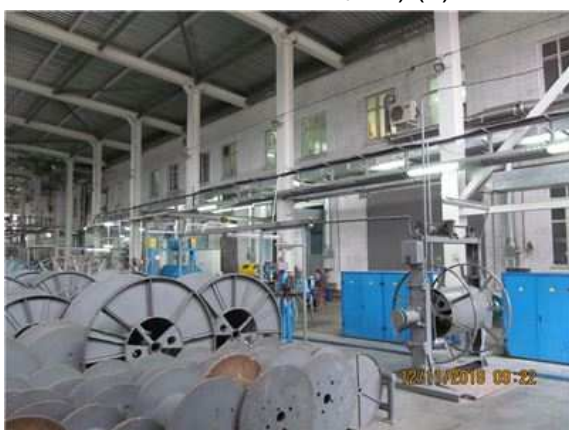
Фото.47 Литер Т (Здание слесарно-механического цеха) (4)
