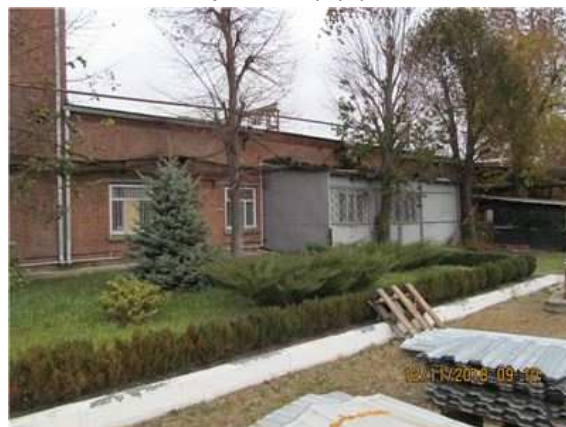
Фото.24 Литер И (Склад и Линейный участок) (1)
