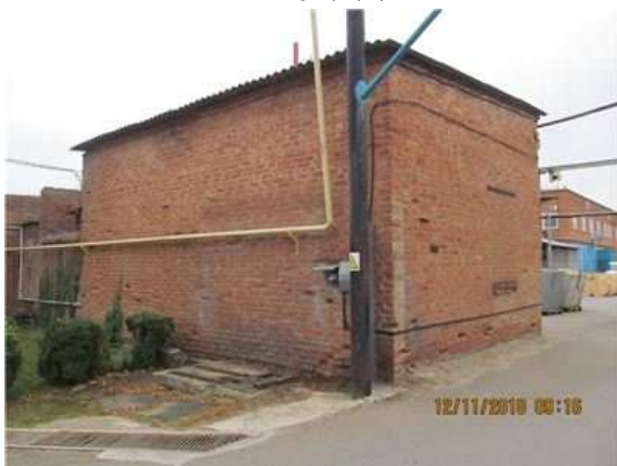
Фото.17 Литер Д1 (Склад) (2)
