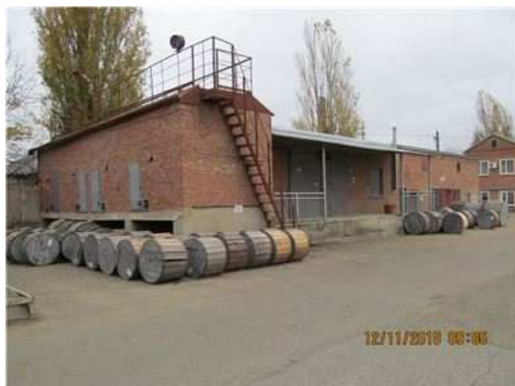
Фото.21 Литер Ж (Склад) (2)
