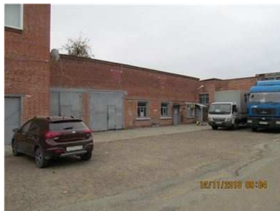
Фото.22 Литер З (Склад и Линейный участок) (1)
