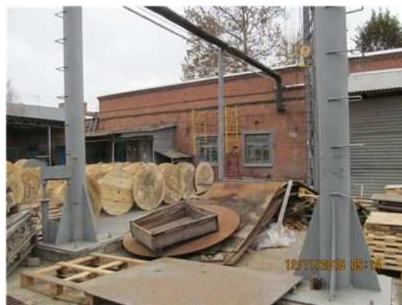
Фото.26 Литер И (Склад и Линейный участок) (5)
