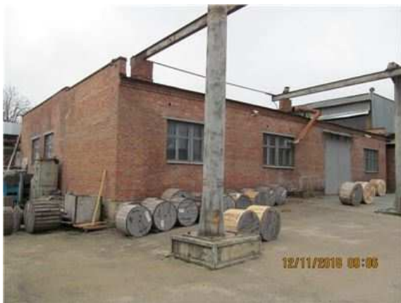
Фото.31 Литер М (Лабораторно-бытовой корпус) (1)
