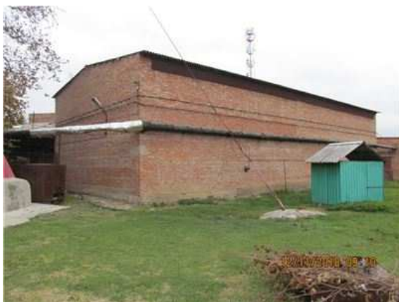
Фото.37 Литер Р (Трубный склад) (1)
