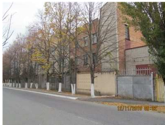
Фото.14 Литер Д (Лабораторно-бытовой корпус) (5)
