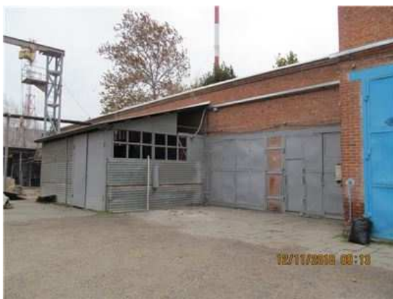
Фото.25 Литер И (Склад и Линейный участок) (4)
