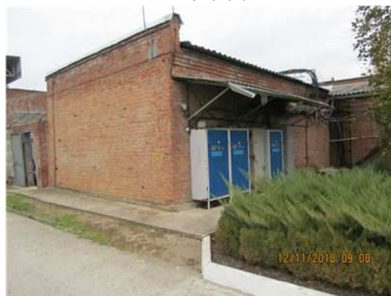
Фото.36 Литер О (Лабораторно-бытовой корпус) (2)
