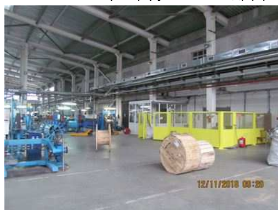
Фото.40 Литер С (Здание ОВК) (3)
