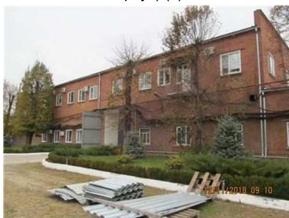
Фото.11 Литер В (Административно-хозяйственное здание) (4)
