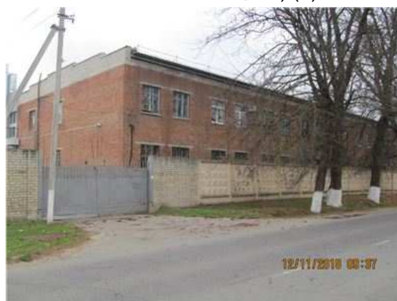
Фото.48 Литер Т (Здание слесарно-механического цеха) (6)
