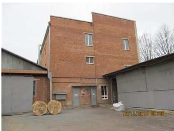
Фото.13 Литер Д (Лабораторно-бытовой корпус) (1)
