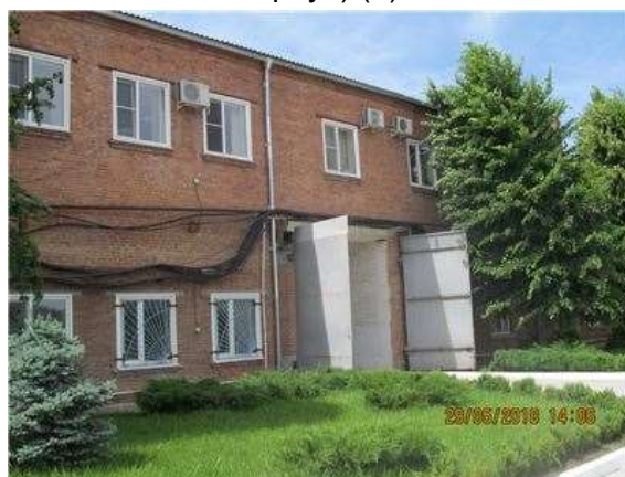
Фото.10 Литер В (Административно-хозяйственное здание) (2)
