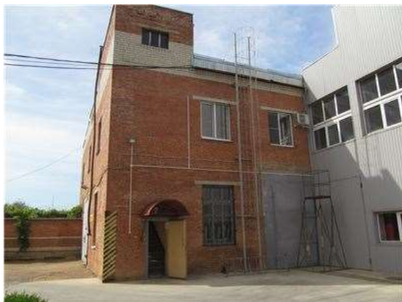
Фото.49 Литер Т (Здание слесарно-механического цеха) (4)
