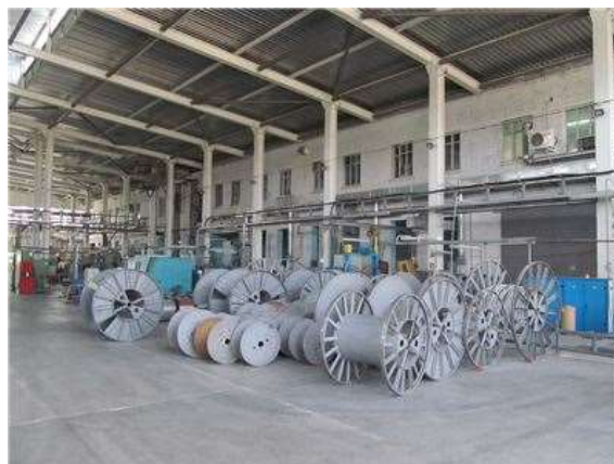
Фото.46 Литер Т (Здание слесарно-механического цеха) (1)
