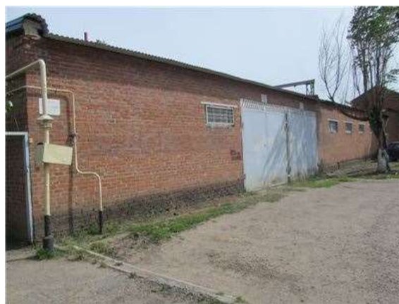
Фото.8 Литер Б (Учебно-производственный корпус) (3)
