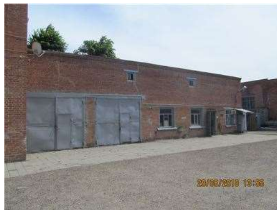
Фото.22 Литер З (Склад и Линейный участок) (1)
