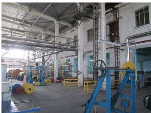
Фото.47 Литер Т (Здание слесарно-механического цеха) (2)
