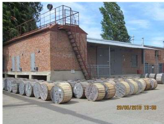
Фото.20 Литер Ж (Склад) (2)
