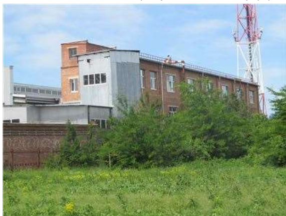
Фото.41 Литер С (Здание ОВК) (1)
