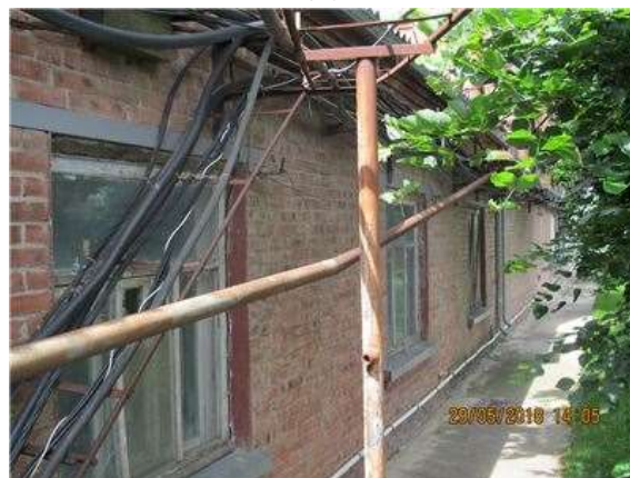
Фото.24 Литер З (Склад и Линейный участок) (3)
