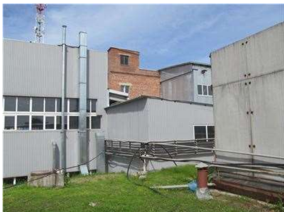
Фото.45 Литер С (Здание ОВК) (5)
