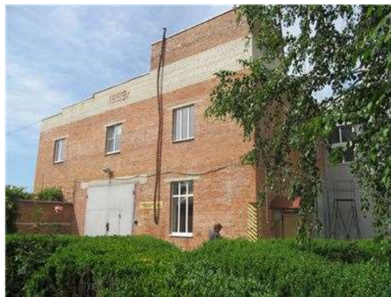
Фото.50 Литер Т (Здание слесарно-механического цеха) (5)
