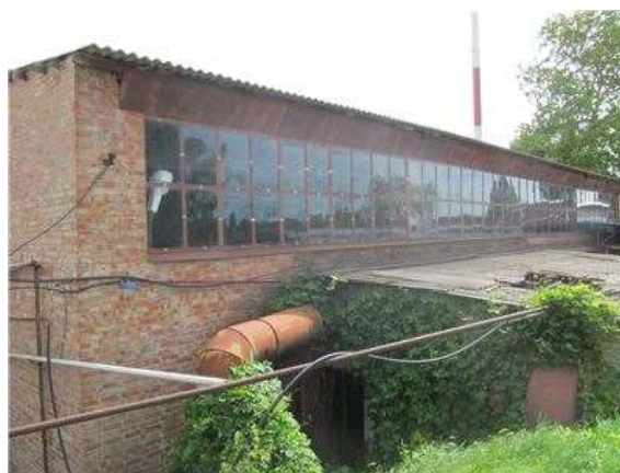
Фото.40 Литер Р (Трубный склад) (3)
