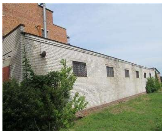
Фото.14 Литер Д (Лабораторно-бытовой корпус) (3)
