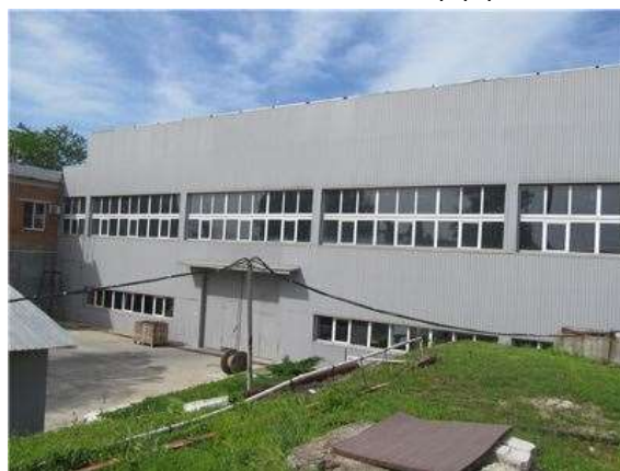
Фото.54 Литер Х (Нежилое здание - цех) (2)
