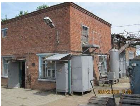
Фото.23 Литер З (Склад и Линейный участок) (2)
