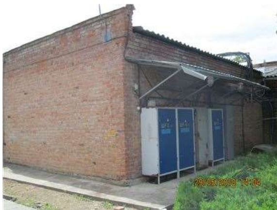
Фото.37 Литер О (Лабораторно-бытовой корпус) (3)
