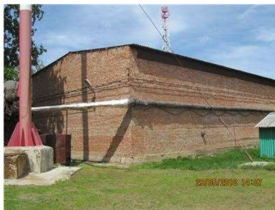
Фото.38 Литер Р (Трубный склад) (1)
