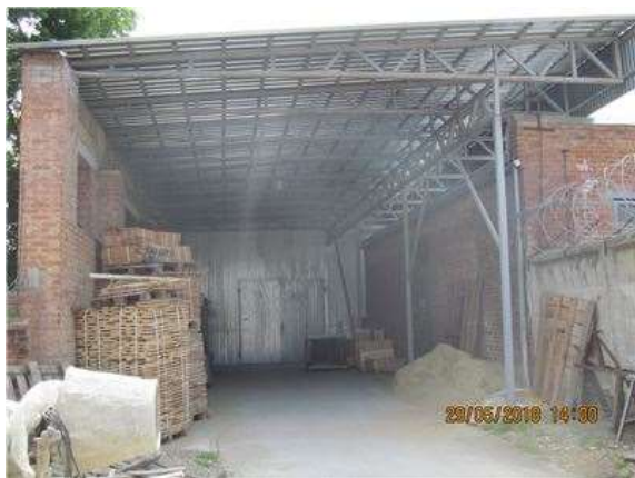
Фото.17 Литер Д2 (Навес) (1)
