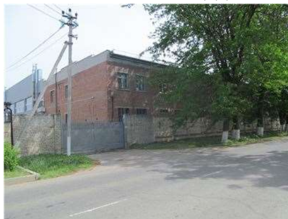
Фото.52 Литер Т (Здание слесарно-механического цеха) (7)
