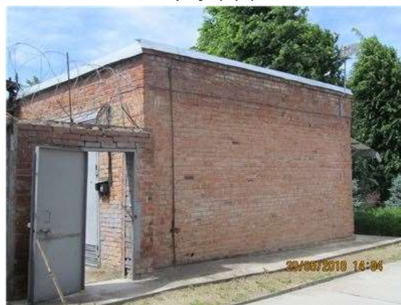
Фото.36 Литер О (Лабораторно-бытовой корпус) (2)
