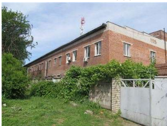
Фото.51 Литер Т (Здание слесарно-механического цеха) (6)
