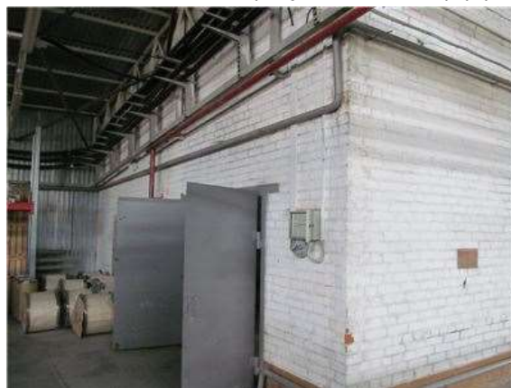
Фото.42 Литер С (Здание ОВК) (2)
