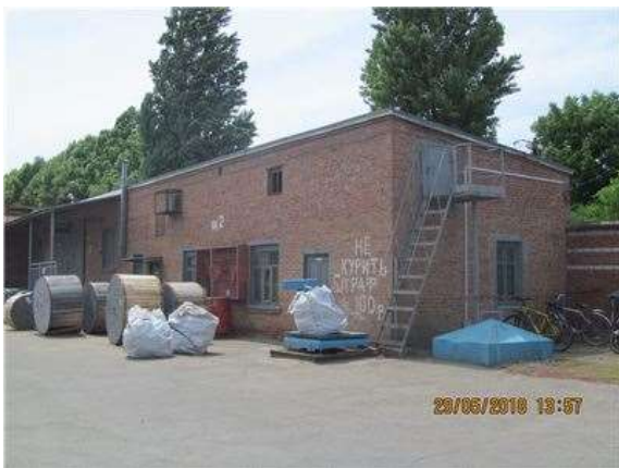
Фото.19 Литер Ж (Склад) (1)
