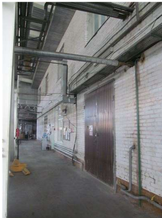
Фото.44 Литер С (Здание ОВК) (4)
