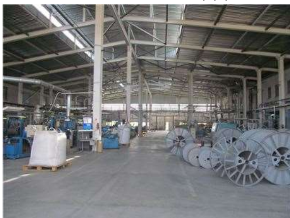
Фото.53 Литер Х (Нежилое здание - цех) (1)
