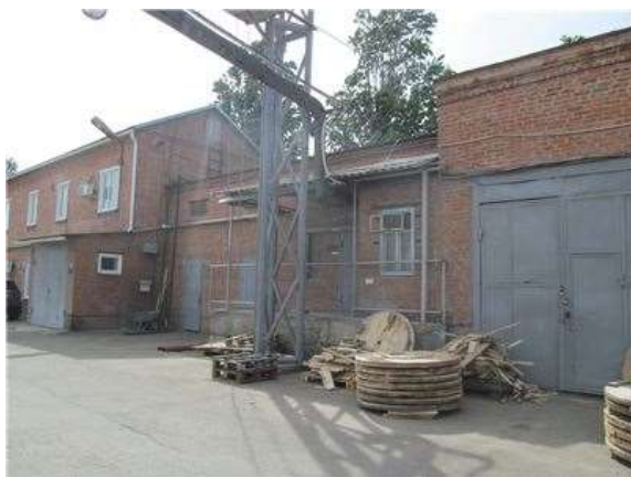
Фото.7 Литер Б (Учебно-производственный корпус) (2)
