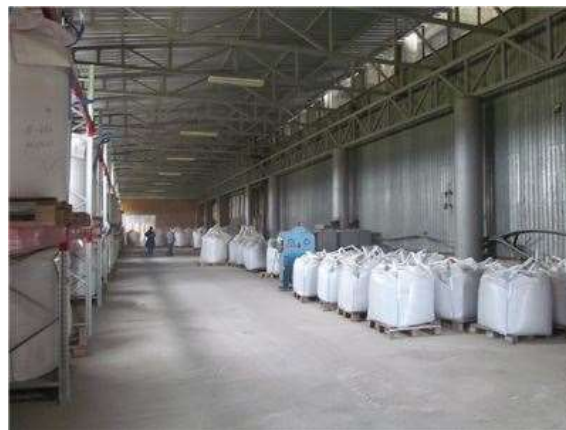
Фото.18 Литер Д2 (Навес) (2)
