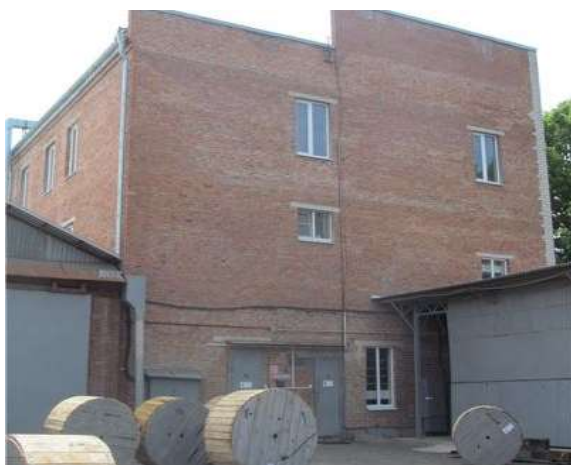
Фото.13 Литер Д (Лабораторно-бытовой корпус) (2)
