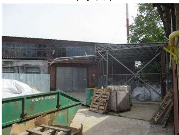
Фото.39 Литер Р (Трубный склад) (2)
