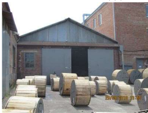
Фото.12 Литер Д (Лабораторно-бытовой корпус) (1)
