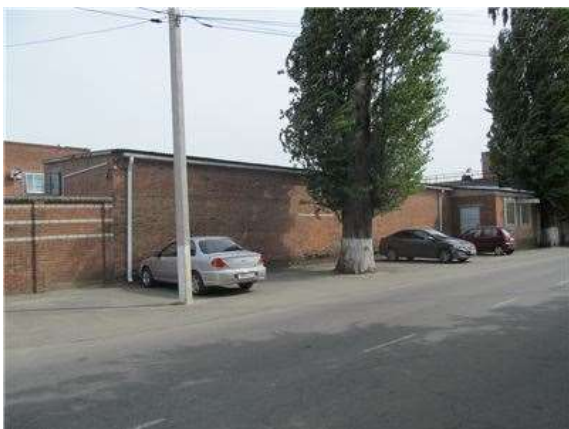
Фото.21 Литер Ж (Склад) (3)
