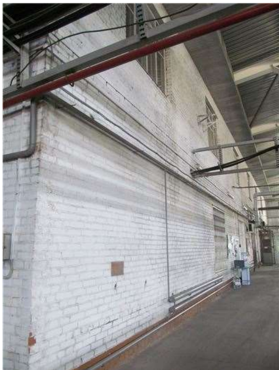
Фото.43 Литер С (Здание ОВК) (3)
