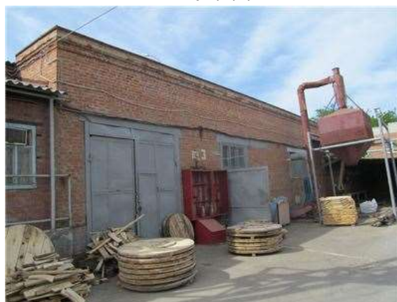
Фото.6 Литер Б (Учебно-производственный корпус) (1)
