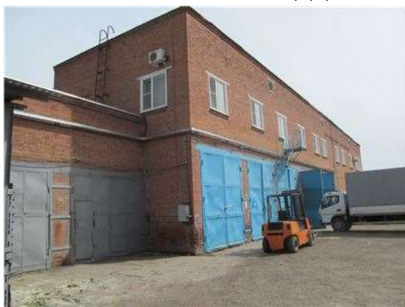
Фото.11 Литер В (Административно-хозяйственное здание) (3)
