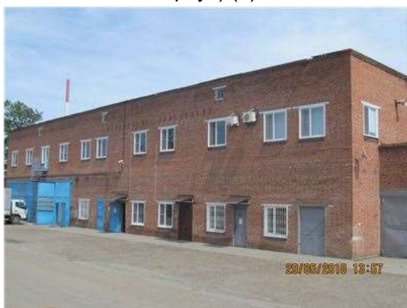
Фото.9 Литер В (Административно-хозяйственное здание) (1)
