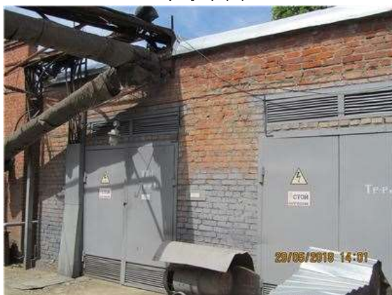
Фото.35 Литер О (Лабораторно-бытовой корпус) (1)
