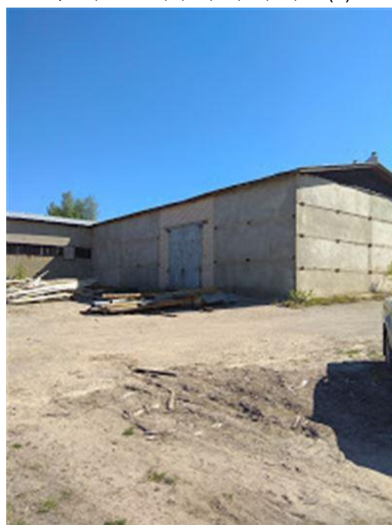
Фото.12 Здание материального склада, лит. Р.Р1.р (1)
