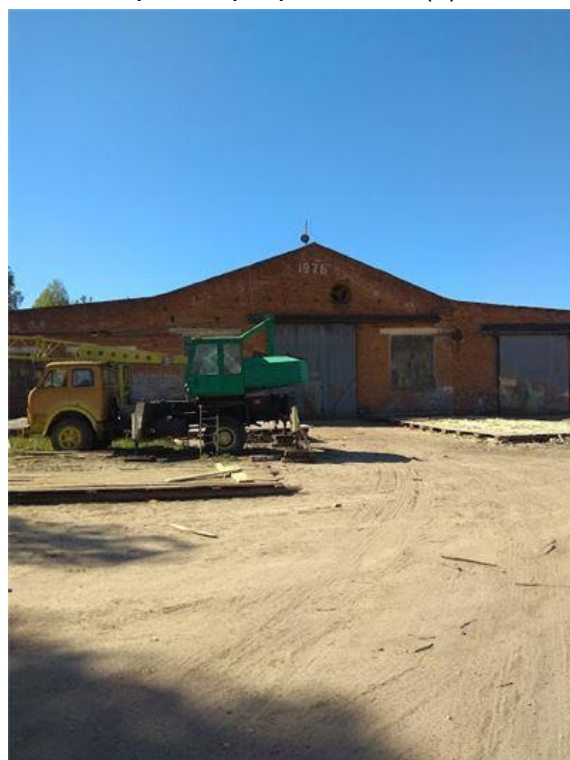
Фото.36 Здание цеха отделки кузовов, лит. М.м (2)
