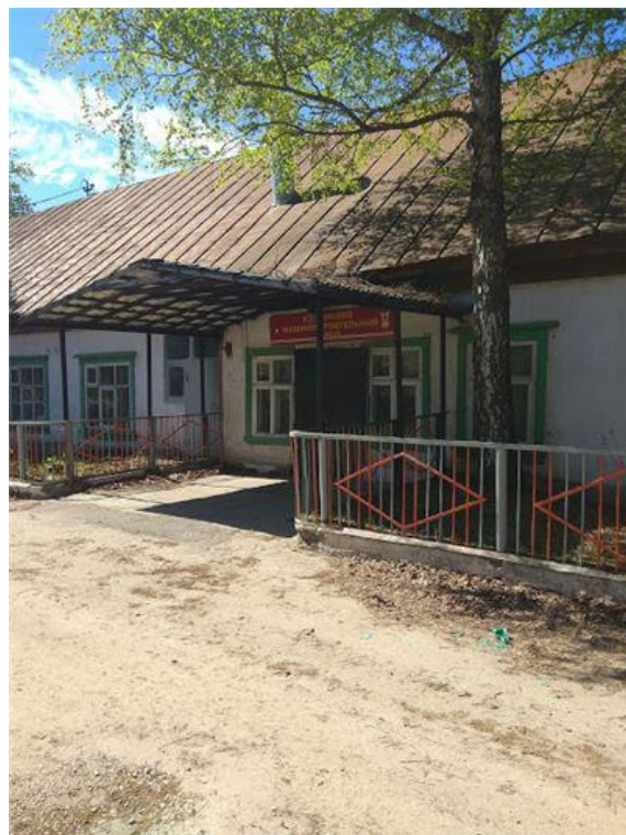
Фото.6 Здание конторы, лит.Х (3)
