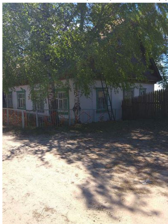
Фото.4 Здание конторы, лит.Х (1)
