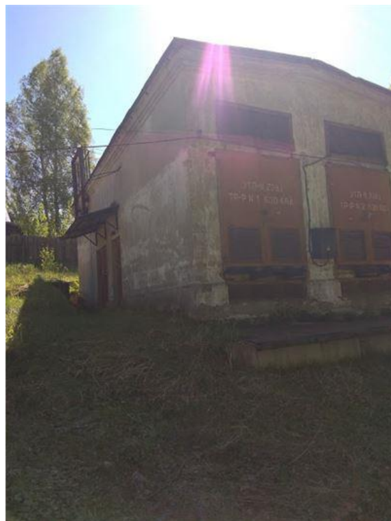
Фото.30 Здание трансформаторной подстанции, лит.Ж (2)
