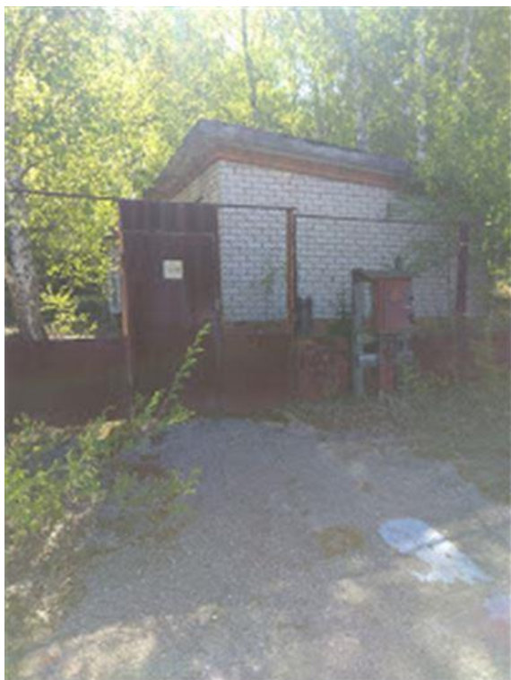
Фото.25 Здание склада ГСМ, лит.С (1)
