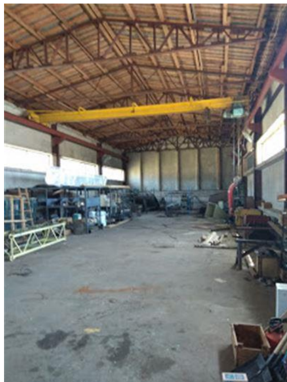
Фото.14 Здание материального склада, лит. Р.Р1.р (3)
