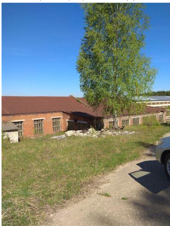
Фото.35 Здание цеха отделки кузовов, лит. М.м (1)
