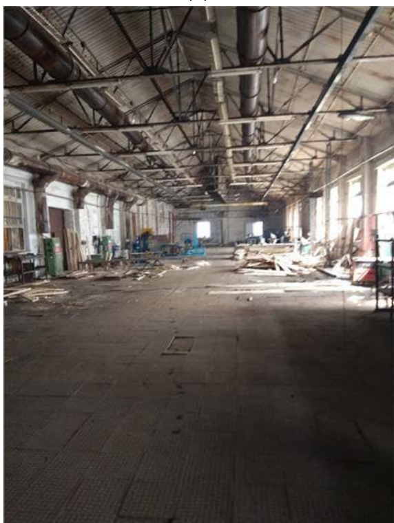
Фото.23 Здание сборочного цеха, лит. О.о (3)
