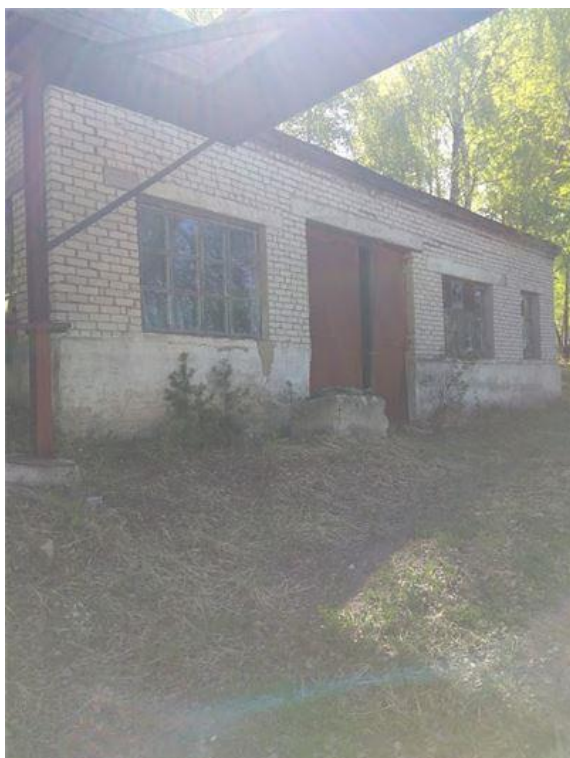
Фото.1 Здание компрессорной, лит.З (1)
