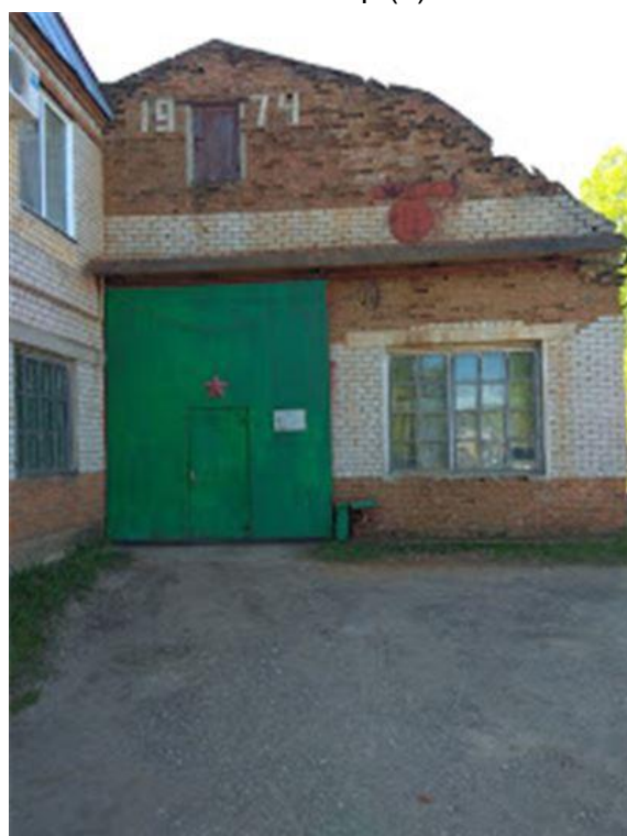
Фото.16 Здание механического цеха, лит. Н.н (1)
