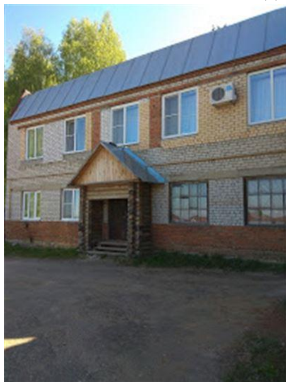
Фото.28 Здание техотдела, лит. Н1 (2)
