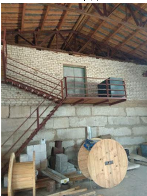
Фото.15 Здание материального склада, лит. Р.Р1.р (4)
