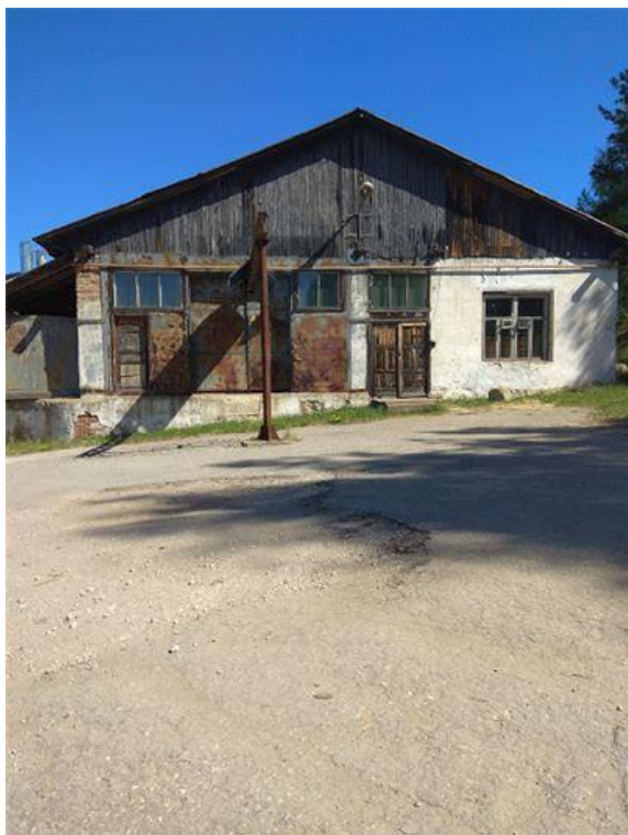
Фото.37 Здание цеха отделки кузовов, лит. М.м (3)
