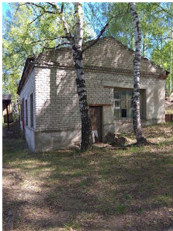
Фото.2 Здание компрессорной, лит.З (2)
