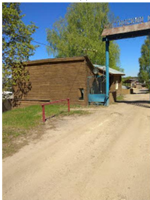
Фото.20 Здание проходной, лит.А, а (2)
