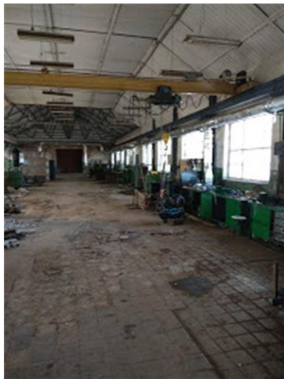
Фото.18 Здание механического цеха, лит. Н.н (3)
