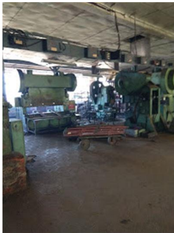
Фото.38 Здание цеха отделки кузовов, лит. М.м (4)
