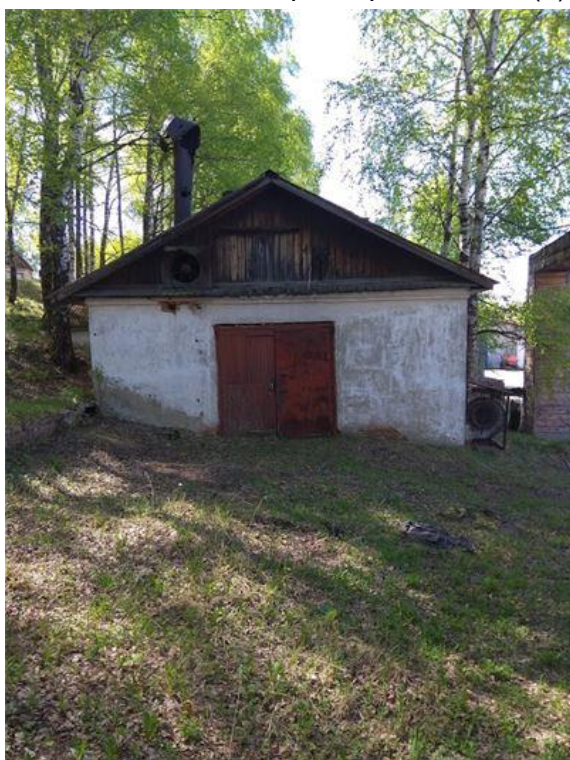
Фото.3 Здание компрессорной, лит.З (3)
