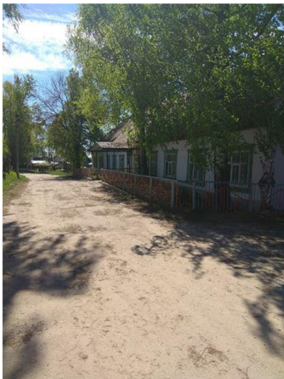
Фото.5 Здание конторы, лит.Х (2)
