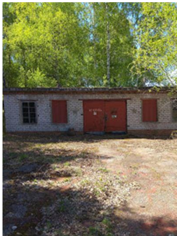
Фото.26 Здание склада ГСМ, лит.С (2)
