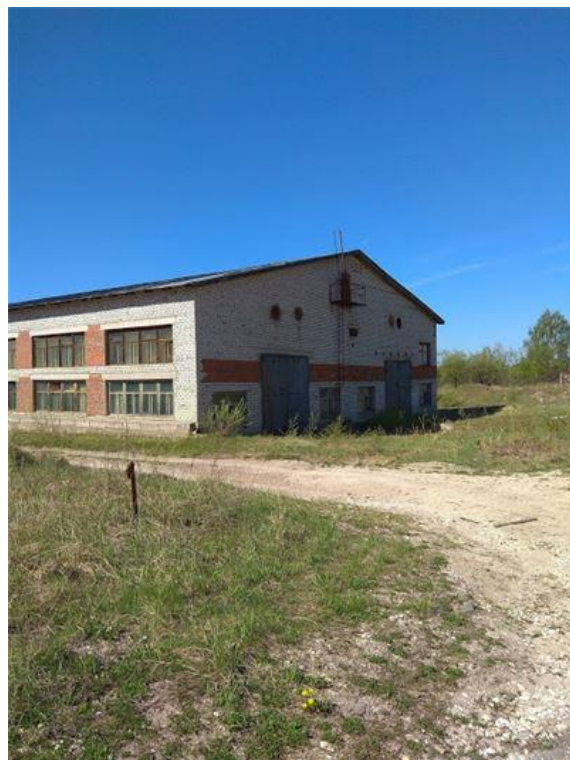
Фото.22 Здание сборочного цеха, лит. О.о (2)
