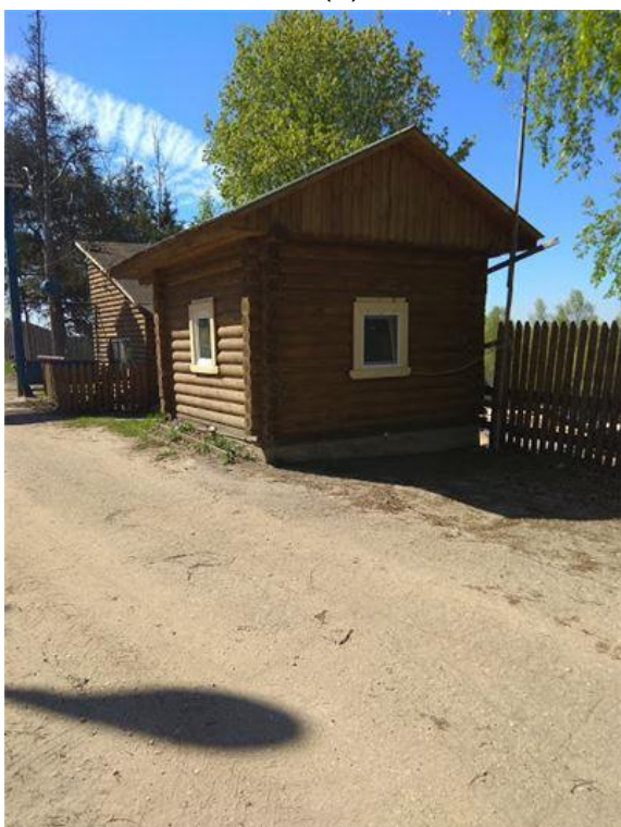
Фото.19 Здание проходной, лит.А, а (1)
