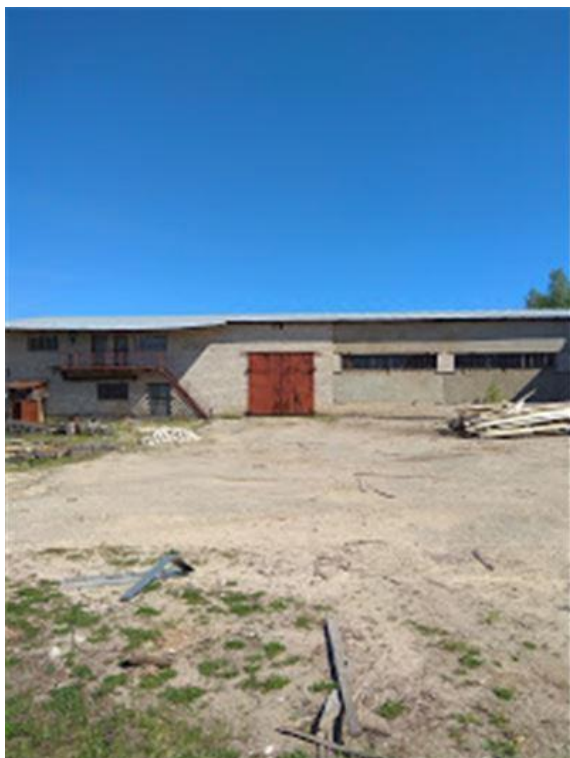
Фото.13 Здание материального склада, лит. Р.Р1.р (2)
