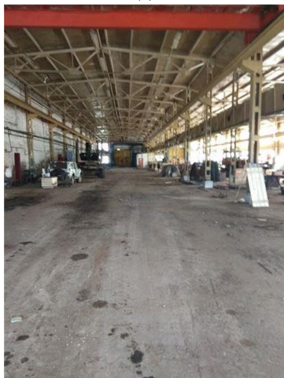
Фото.24 Здание сборочного цеха, лит. О.о (4)
