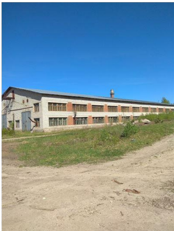
Фото.21 Здание сборочного цеха, лит. О.о (1)
