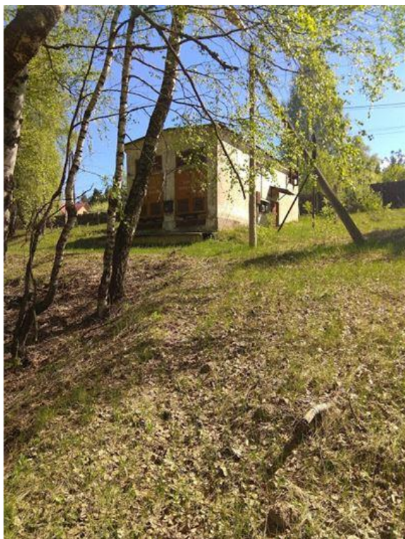
Фото.29 Здание трансформаторной подстанции, лит.Ж (1)
