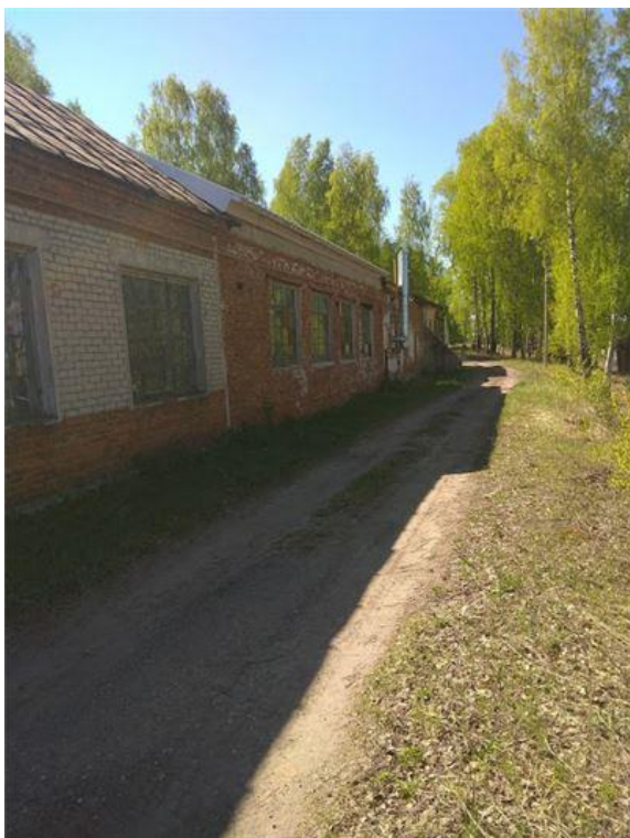
Фото.17 Здание механического цеха, лит. Н.н (2)
