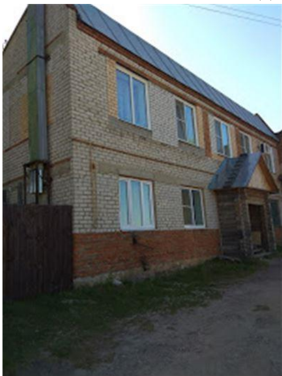
Фото.27 Здание техотдела, лит. Н1 (1)
