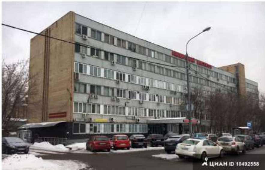
Фото.1 Внешний вид здания
