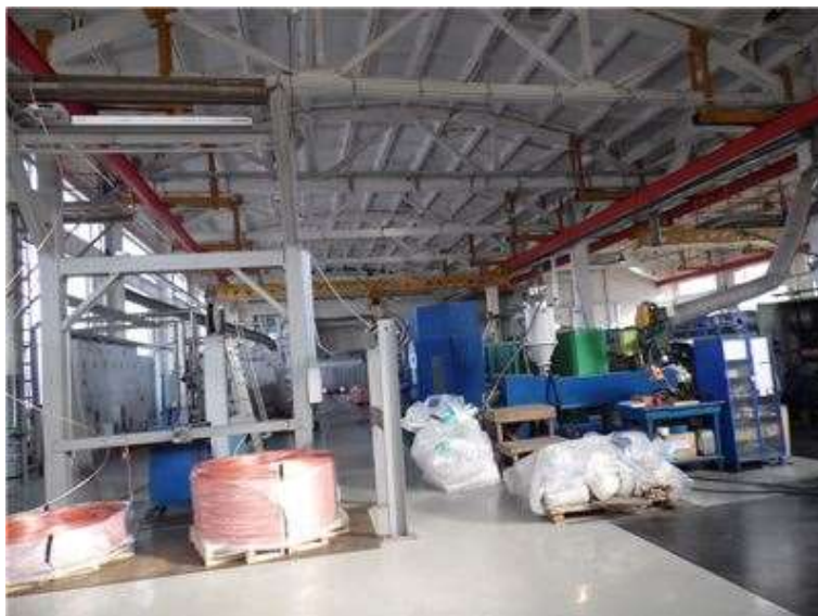
Фото.13 Литер Аа Разборочный цех
