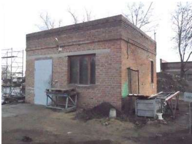
Фото.19 Литер Щ здание насосной
