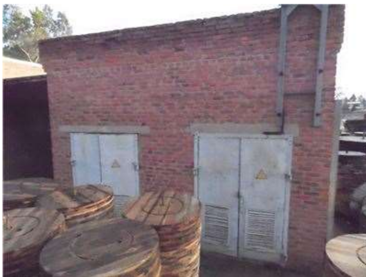
Фото.20 Литер Я здание электростанции
