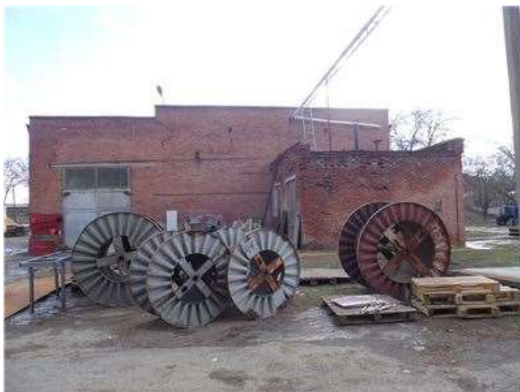
Фото.17 Литер Д,нД,д Здание производственного склада
