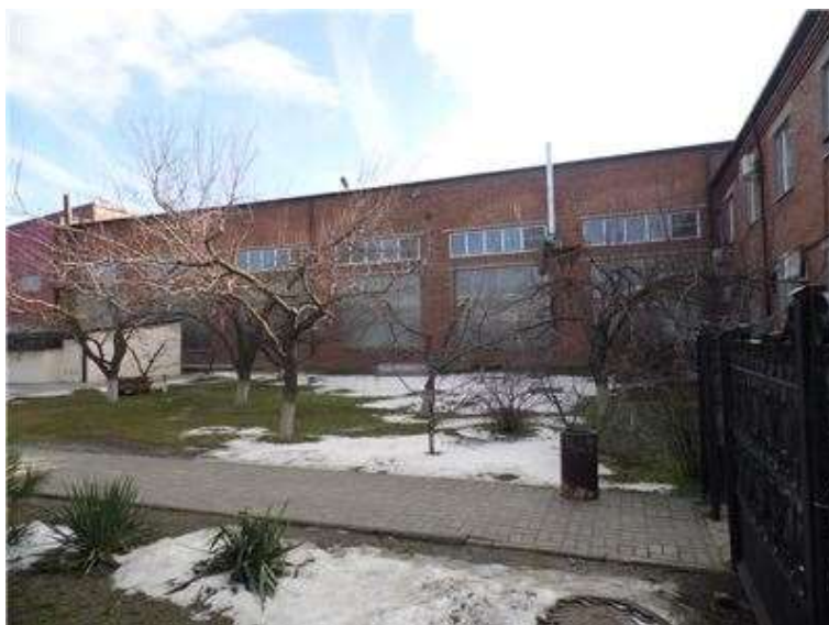
Фото.15 Литер Аа Разборочный цех
