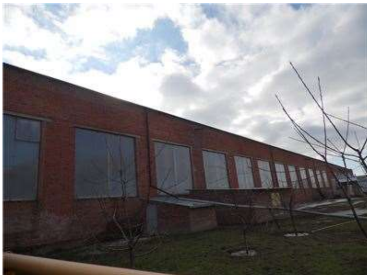
Фото.12 Литер А4, А5 Приемо-сдаточный цех
