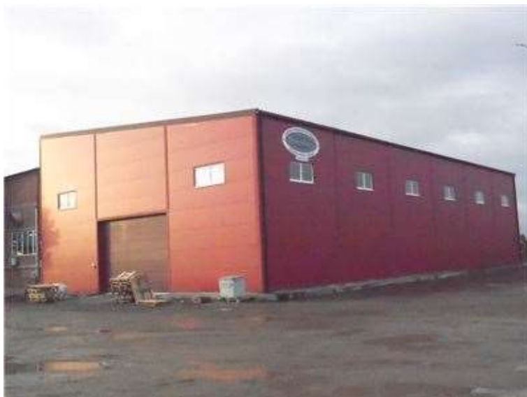
Фото.16 Литер Б Здание склада
