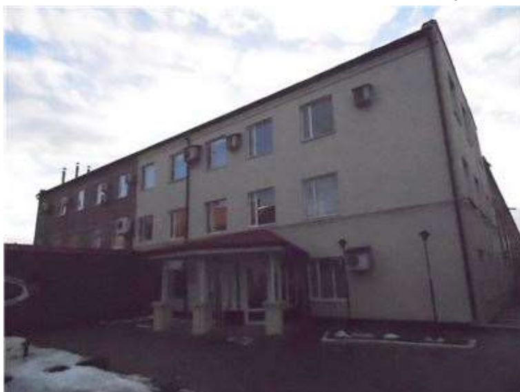
Фото.8 Литер А3 Главный корпус
