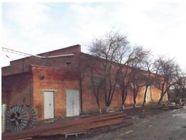
Фото.18 Литер Д,нД,д Здание производственного склада
