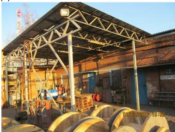
Фото.29 Литер К (Склад и Линейный участок) (2)
