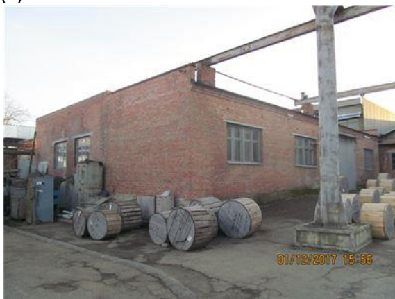
Фото.31 Литер М (Лабораторно-бытовой корпус) (1)
