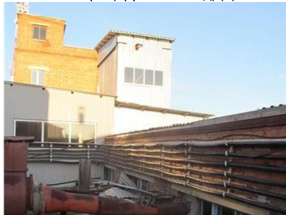
Фото.46 Литер С и Т (Здание ОВК) (1)
