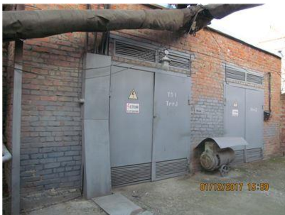
Фото.35 Литер О (Лабораторно-бытовой корпус) (1)
