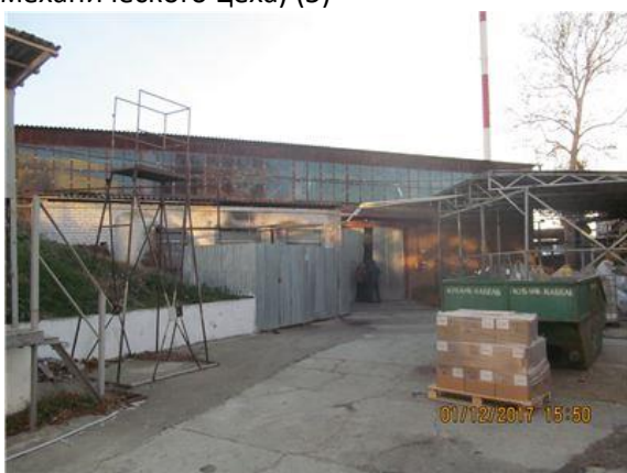
Фото.43 Литер Р (Трубный склад) (1)
