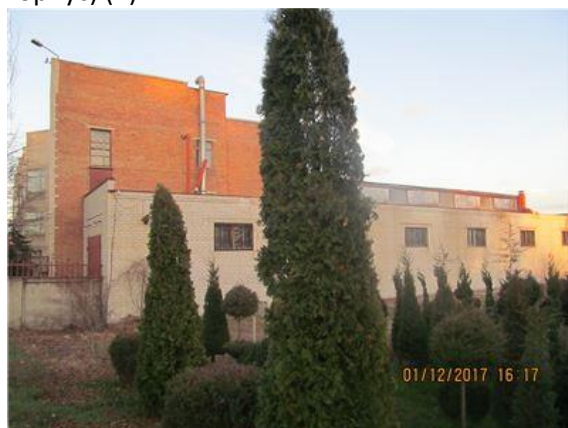
Фото.16 Литер Д (Лабораторно-бытовой корпус) (3)
