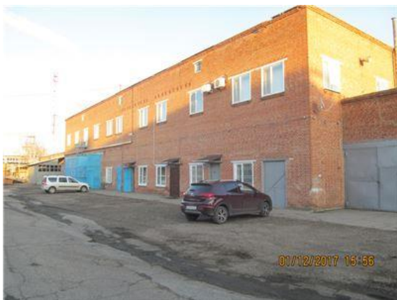
Фото.13 Литер В (Административно-хозяйственное здание) (3)
