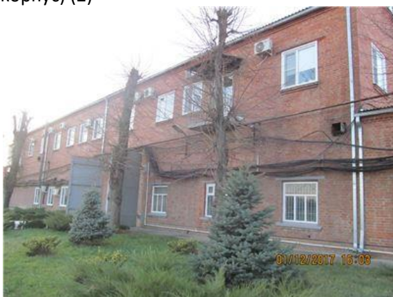
Фото.11 Литер В (Административно-хозяйственное здание) (1)
