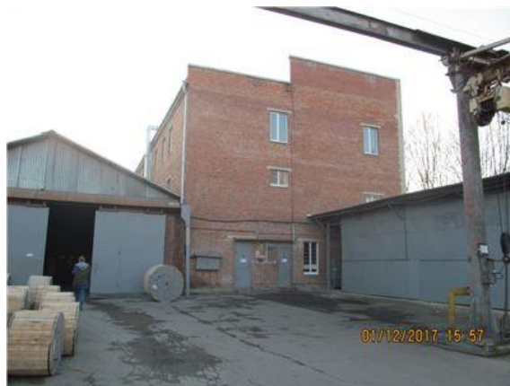
Фото.14 Литер Д (Лабораторно-бытовой корпус) (1)
