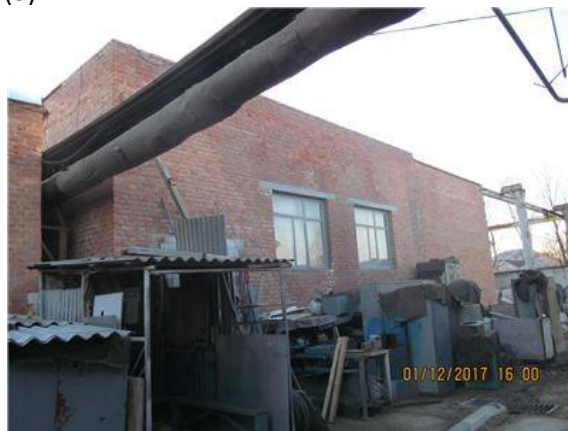
Фото.32 Литер М (Лабораторно-бытовой корпус) (2)
