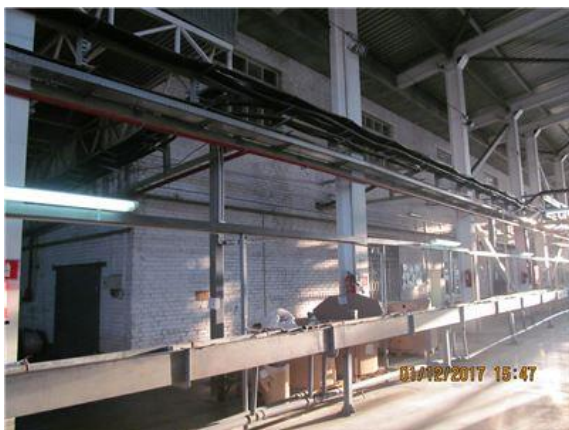
Фото.49 Литер С и Т (Здание ОВК) (4)
