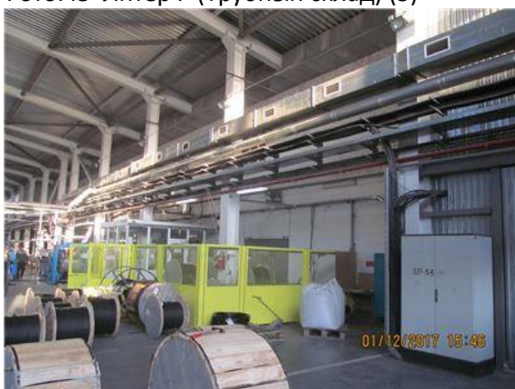
Фото.47 Литер С и Т (Здание ОВК) (2)
