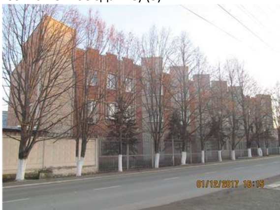
Фото.15 Литер Д (Лабораторно-бытовой корпус) (2)
