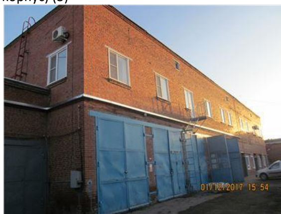
Фото.12 Литер В (Административно-хозяйственное здание) (2)
