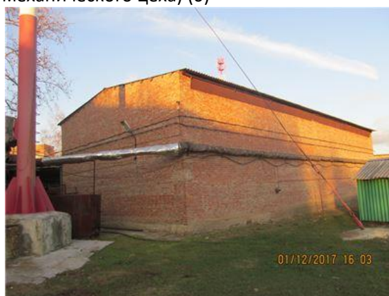
Фото.44 Литер Р (Трубный склад) (2)
