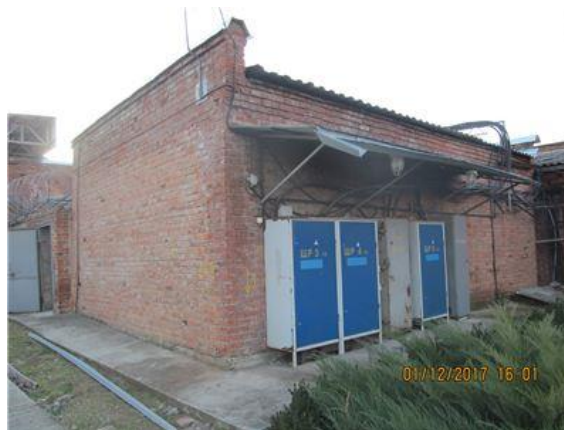
Фото.36 Литер О (Лабораторно-бытовой корпус) (2)
