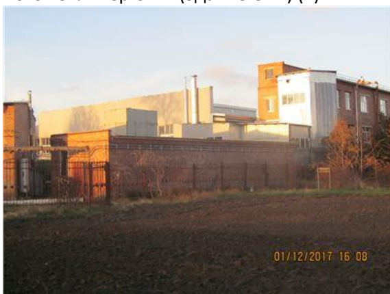
Фото.51 Литер С и Т (Здание ОВК) (6)
