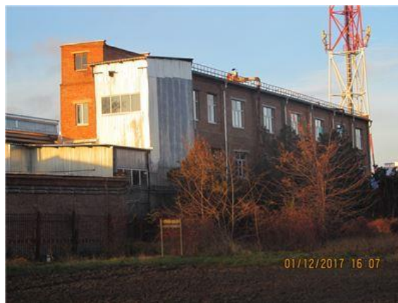
Фото.50 Литер С и Т (Здание ОВК) (5)
