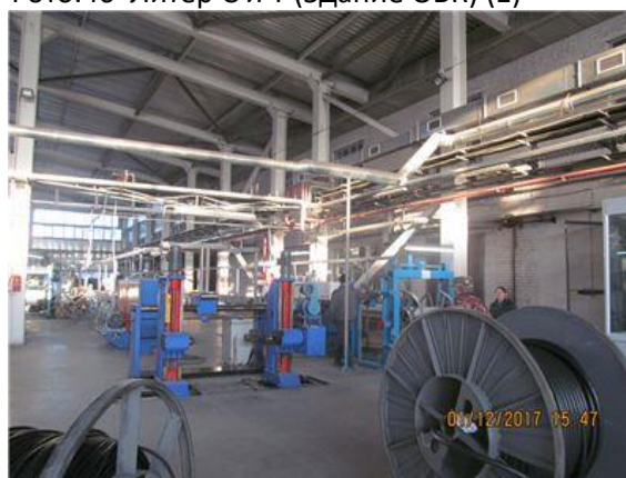
Фото.48 Литер С и Т (Здание ОВК) (3)
