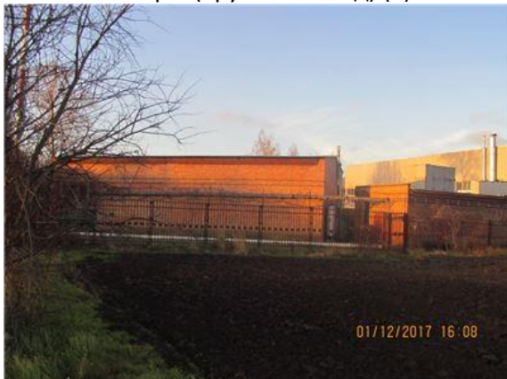
Фото.45 Литер Р (Трубный склад) (3)
