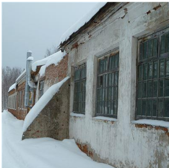
Рис. 17 Здание механического цеха, лит. Н.н (3)
