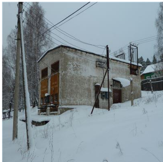
Рис. 34 Здание трансформаторной подстанции, лит.Ж (2)
