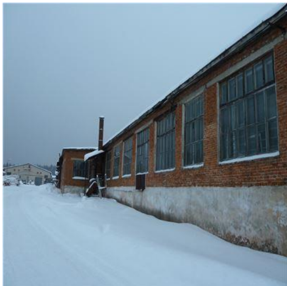
Рис. 25 Здание сборочного цеха, лит. О.о (4)
