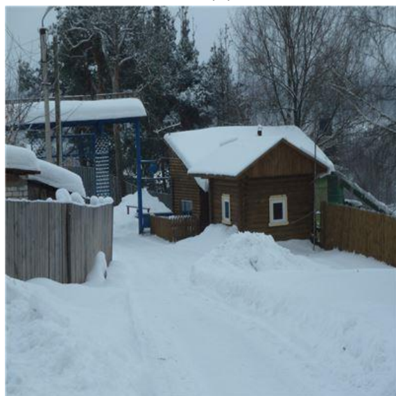
Рис. 20 Здание проходной, лит.А, а (2)
