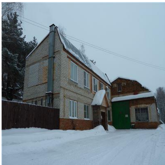
Рис. 31 Здание техотдела, лит. Н1 (1)
