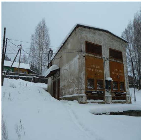
Рис. 33 Здание трансформаторной подстанции, лит.Ж (1)
