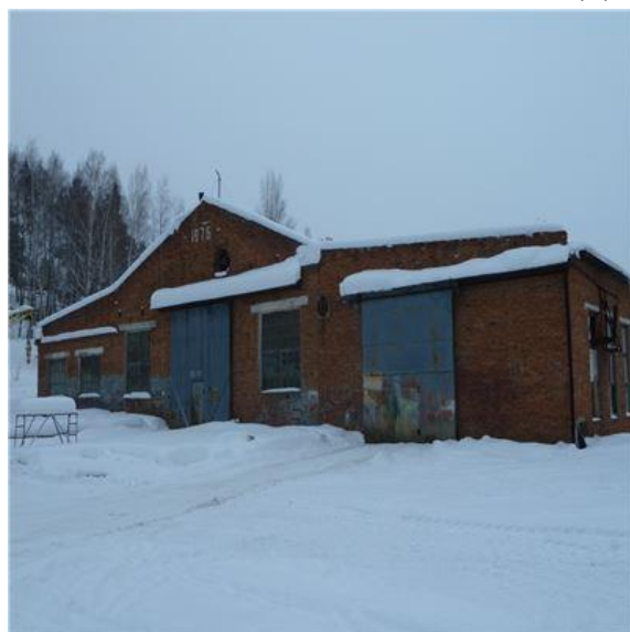
Рис. 22 Здание сборочного цеха, лит. О.о
