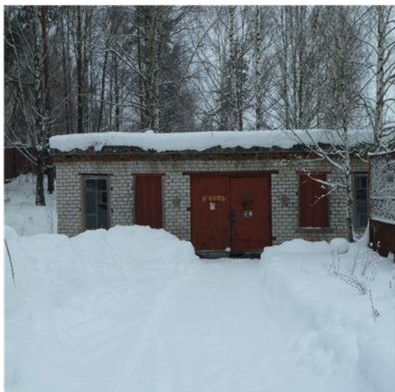
Рис. 29 Здание склада ГСМ, лит.С (3)
