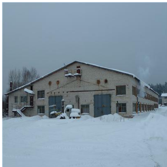
Рис. 40 Здание Цех отделки кузовов, М, м (3)
