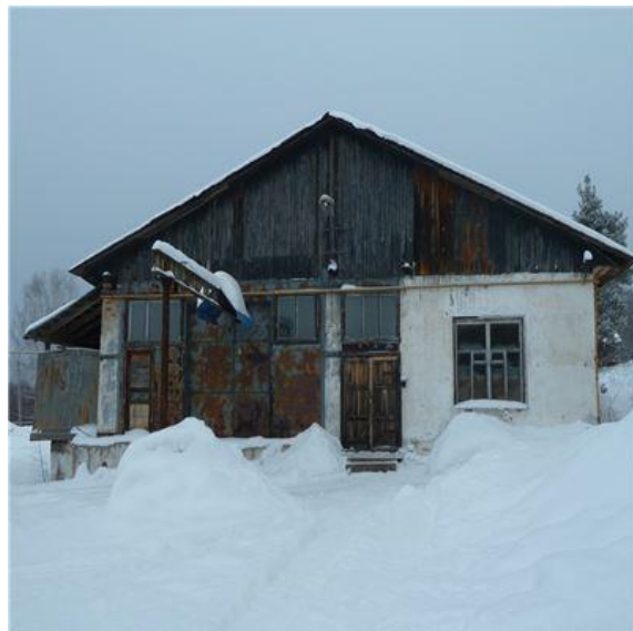
Рис. 24 Здание сборочного цеха, лит. О.о (3)
