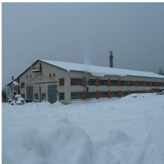
Рис. 39 Здание Цех отделки кузовов, М, м (2)
