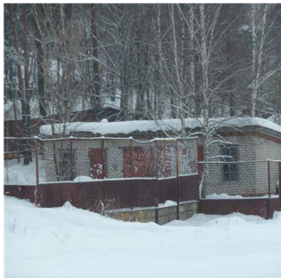
Рис. 28 Здание склада ГСМ, лит.С (2)
