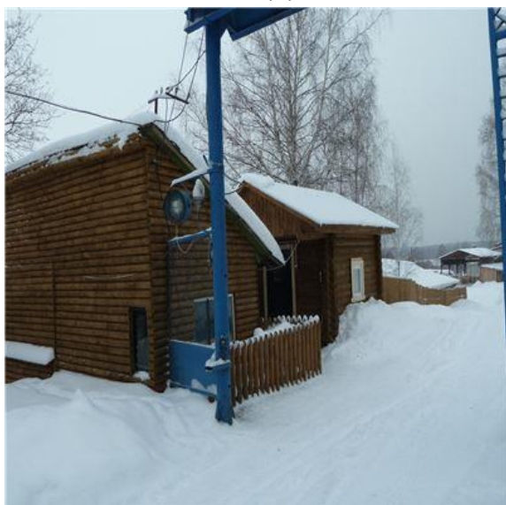
Рис. 19 Здание проходной, лит.А, а (1)
