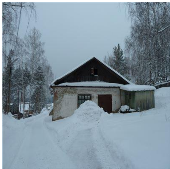
Рис. 18 Здание механического цеха, лит. Н.н (4)
