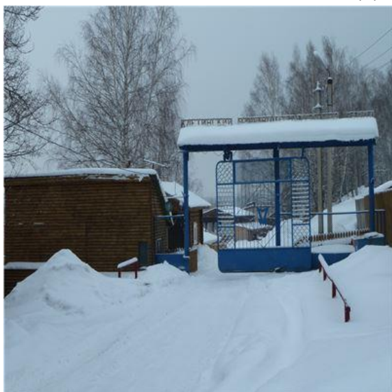
Рис. 21 Здание проходной, лит.А, а (3)
