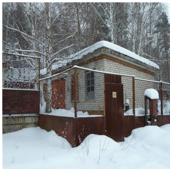
Рис. 30 Здание склада ГСМ, лит.С (4)
