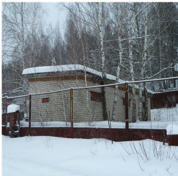
Рис. 27 Здание склада ГСМ, лит.С (1)
