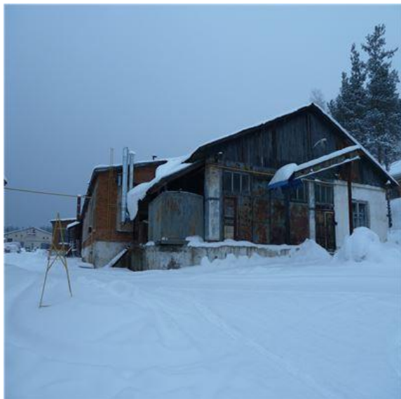
Рис. 23 Здание сборочного цеха, лит. О.о (2)
