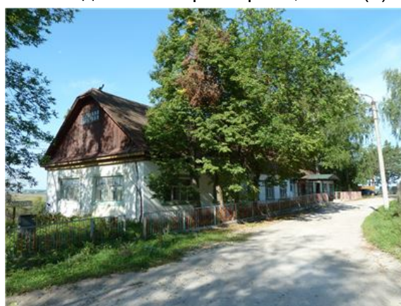
Рис. 4 Здание конторы лит.Х (2)
