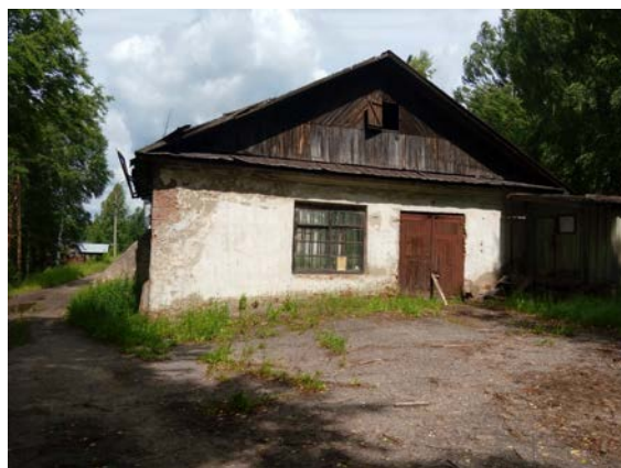
Рис. 14 Здание механического цеха, лит.Н, н, (2)
