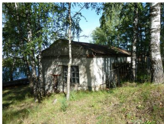
Рис. 2 Здание компрессорной, лит.З (2)
