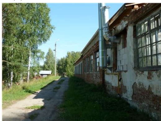
Рис. 15 Здание механического цеха, лит.Н, н, (3)
