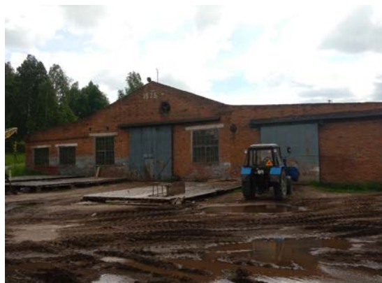
Рис. 20 Здание сборочного цеха, лит.О, о (1)
