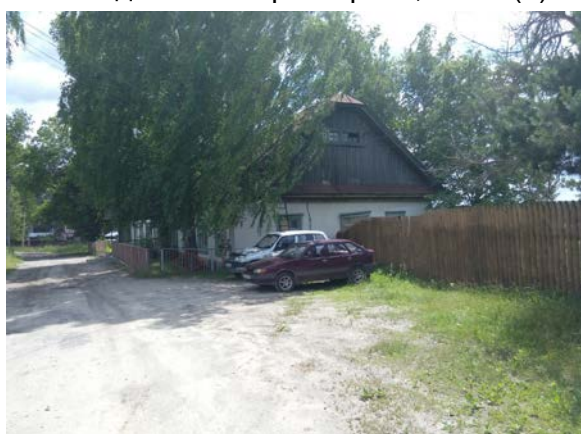
Рис. 3 Здание конторы лит.Х (1)
