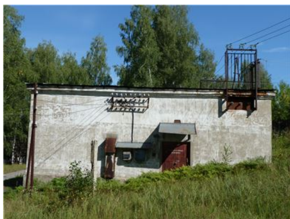
Рис. 31 Здание трансформаторной подстанции, лит.Ж (1)
