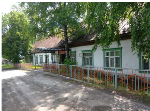
Рис. 5 Здание конторы лит.Х (3)
