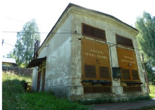
Рис. 33 Здание трансформаторной подстанции, лит.Ж (3)
