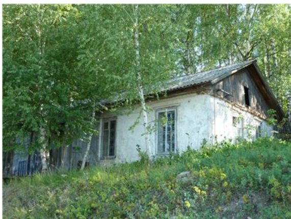
Рис. 41 Здание электроцеха, кузницы, лит.Д, д (1)
