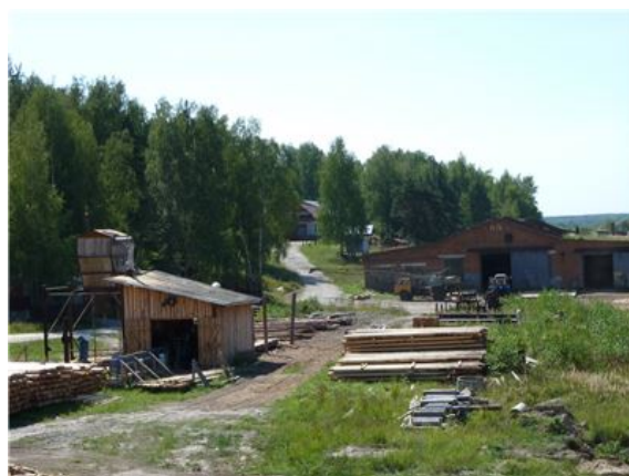
Рис. 48 Земельный участок под зданиями базы (4)
