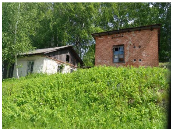
Рис. 44 Здание электроцеха, кузницы, лит.Д, д (4)
