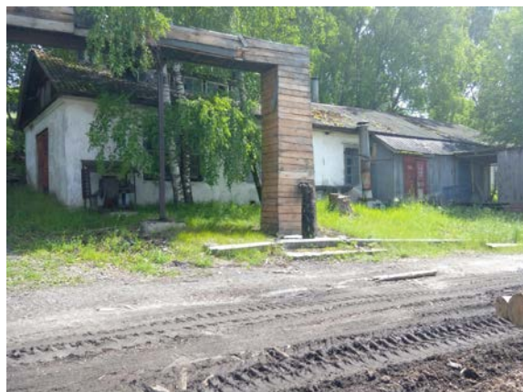
Рис. 42 Здание электроцеха, кузницы, лит.Д, д (2)
