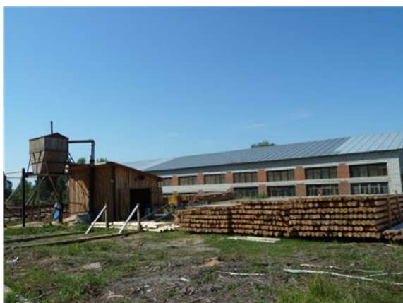
Рис. 45 Земельный участок под зданиями базы (1)
