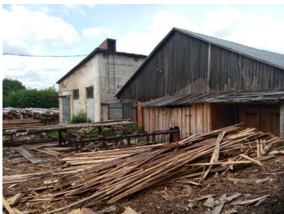
Рис. 10 Здание лесопильного и малярного цеха, лит.И, и, и1, и2, и3, и4, и5 (5)
