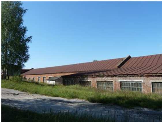
Рис. 23 Здание сборочного цеха, лит.О, о (4)
