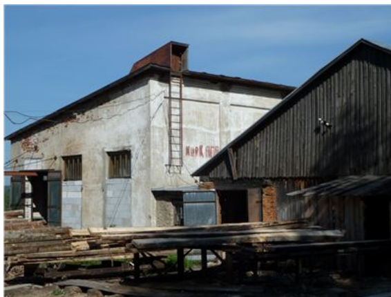
Рис. 8 Здание лесопильного и малярного цеха, лит.И, и, и1, и2, и3, и4, и5 (3)
