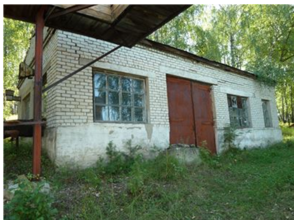
Рис. 1 Здание компрессорной, лит.З (1)
