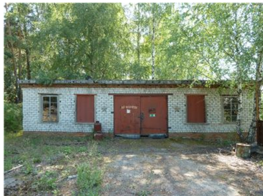
Рис. 28 Здание склада ГСМ, лит.С (4)
