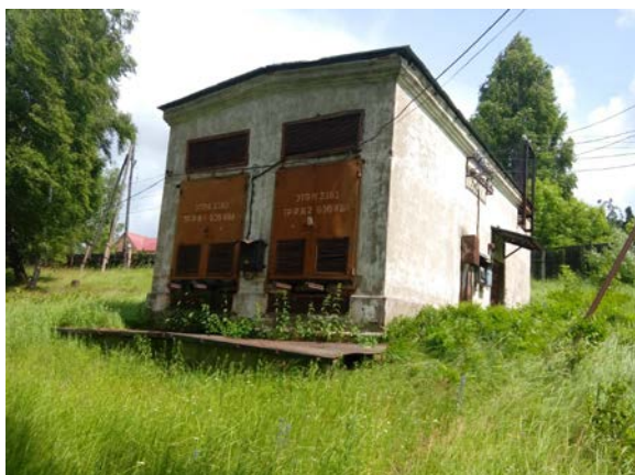
Рис. 32 Здание трансформаторной подстанции, лит.Ж (2)
