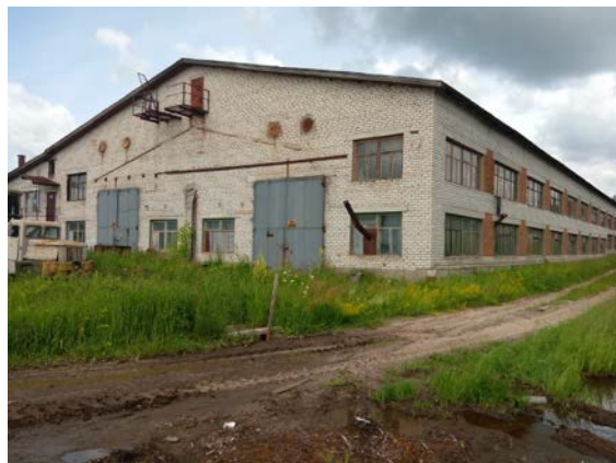
Рис. 38 Здание цеха отделки кузовов, лит.М, м (2)
