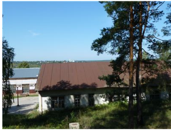
Рис. 22 Здание сборочного цеха, лит.О, о (3)
