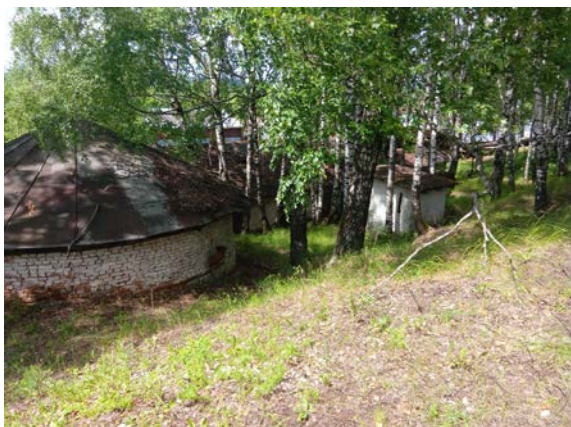
Рис. 43 Здание электроцеха, кузницы, лит.Д, д (3)
