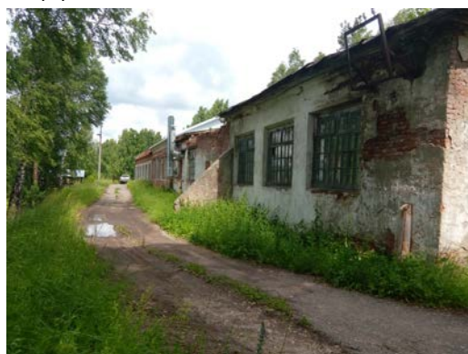
Рис. 16 Здание механического цеха, лит.Н, н, (4)
