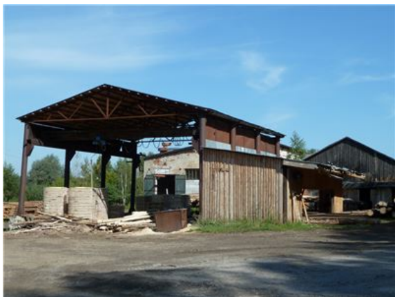
Рис. 7 Здание лесопильного и малярного цеха, лит.И, и, и1, и2, и3, и4, и5 (2)
