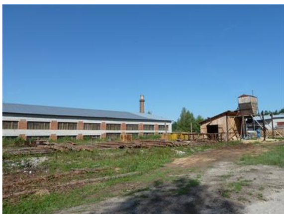
Рис. 39 Здание цеха отделки кузовов, лит.М, м (3)
