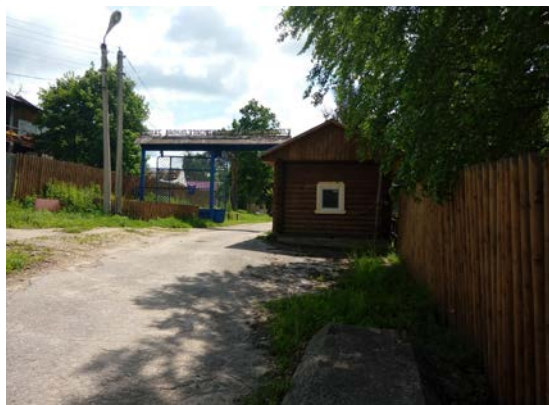
Рис. 19 Здание проходной, лит.А, а (3)
