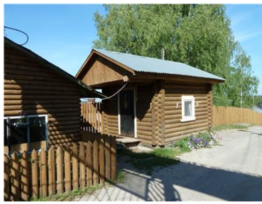
Рис. 18 Здание проходной, лит.А, а (2)
