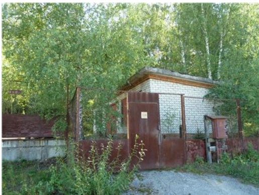
Рис. 27 Здание склада ГСМ, лит.С (3)
