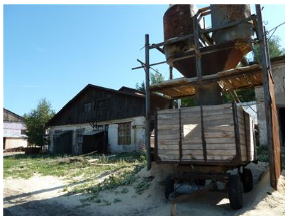
Рис. 12 Здание лесопильного и малярного цеха, лит.И, и, и1, и2, и3, и4, и5 (7)
