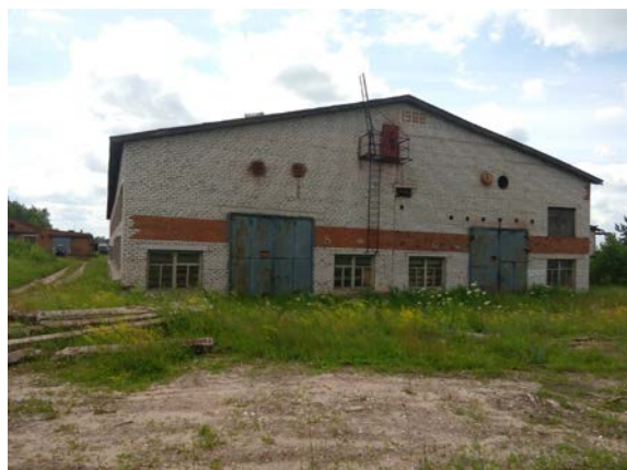
Рис. 40 Здание цеха отделки кузовов, лит.М, м (4)
