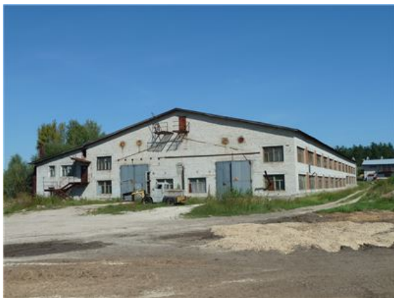
Рис. 37 Здание цеха отделки кузовов, лит.М, м (1)
