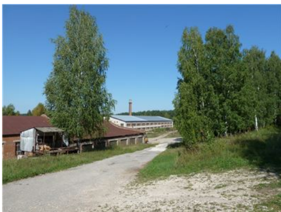
Рис. 47 Земельный участок под зданиями базы (3)
