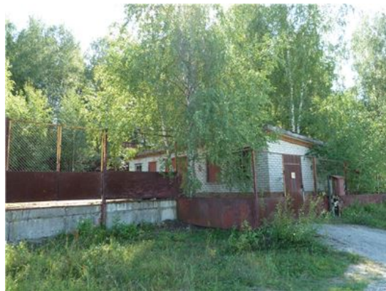
Рис. 26 Здание склада ГСМ, лит.С (2)
