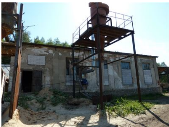
Рис. 11 Здание лесопильного и малярного цеха, лит.И, и, и1, и2, и3, и4, и5 (6)
