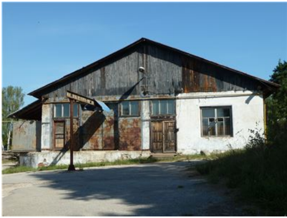
Рис. 21 Здание сборочного цеха, лит.О, о (2)
