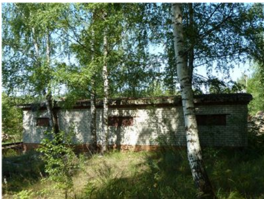
Рис. 25 Здание склада ГСМ, лит.С (1)
