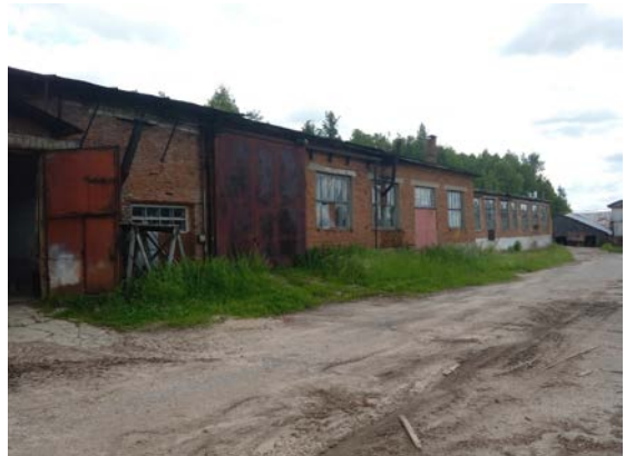
Рис. 24 Здание сборочного цеха, лит.О, о (5)
