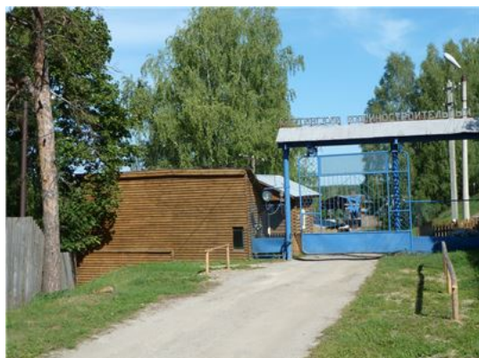
Рис. 17 Здание проходной, лит.А, а (1)
