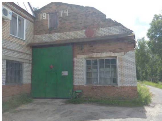
Рис. 13 Здание механического цеха, лит.Н, н, (1)
