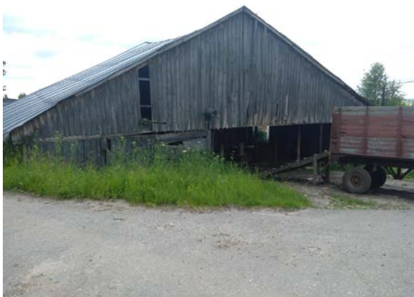
Рис. 9 Здание лесопильного и малярного цеха, лит.И, и, и1, и2, и3, и4, и5 (4)
