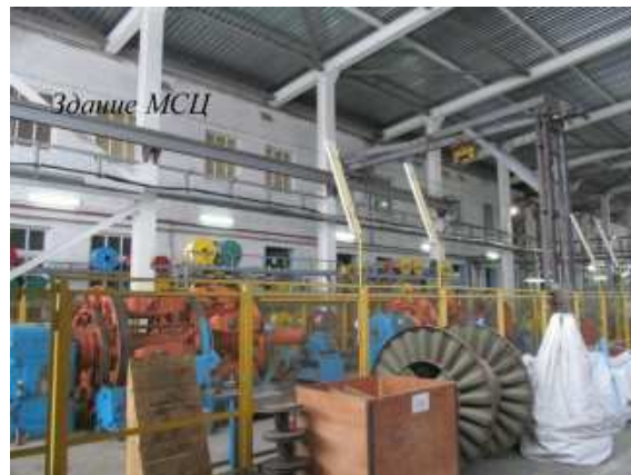
Фото.2 Здание слесарно механического цеха (1)
