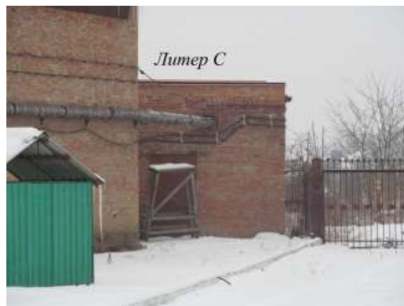
Фото.32 Литер С Здание ОВК
