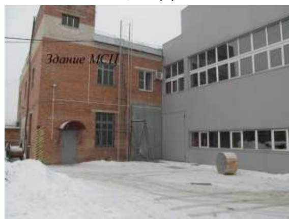
Фото.4 Здание слесарно механического цеха (3)
