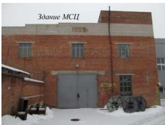
Фото.3 Здание слесарно механического цеха (2)
